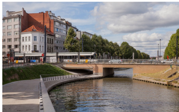
Obrázek 3: Podjezd pod mostem Rozemarijn. ©City of Ghent
