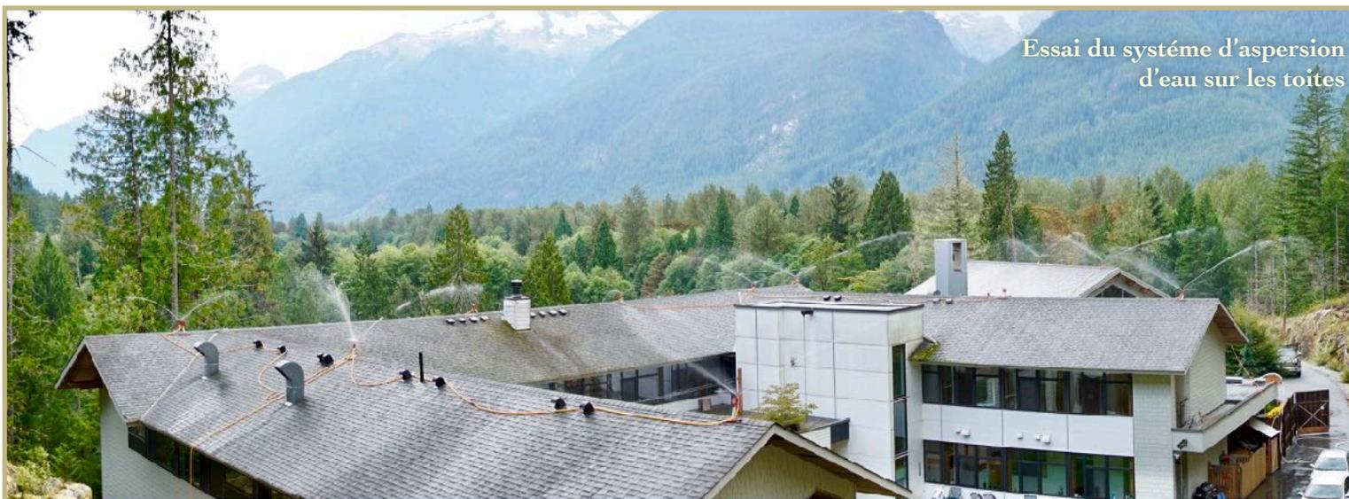
Essai du système d'aspersion d'eau sur les toits
