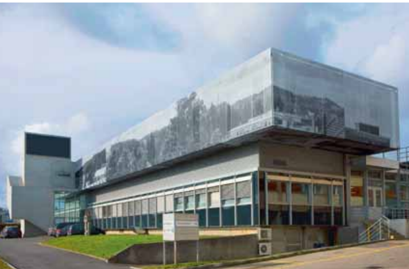
Die diskrete, doch leistungsfähige Produktionsstätte La Joux-Perret in La Chaux-de-Fonds, eine gut ausgestattete Manufaktur mit grosser Produktionskapazität.
