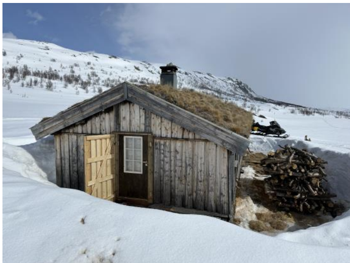
I 2023 oppgraderte vi de låste rommene i Sandbakkbue og Nybue og gjorde dem klare til utleie. Vi fikk støtte fra Grunneierfondet til arbeidet.
