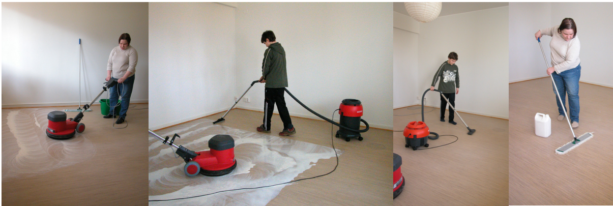
Linoleumin kunnostusvaiheet. Runkola 2005. Kuvat: RW.
