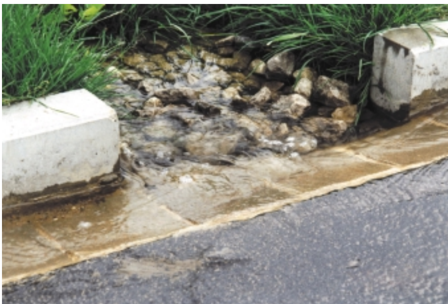
Muldenzulauf mit Schotterpackung
