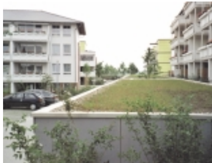
Carport mit Dachbegrünung
