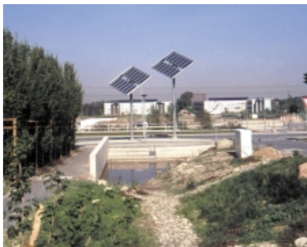
Photovoltaikanlage in der Hangallee Weinkampswende
