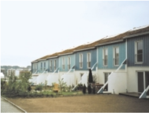
Reihenhäuser mit Dachbegrünung
