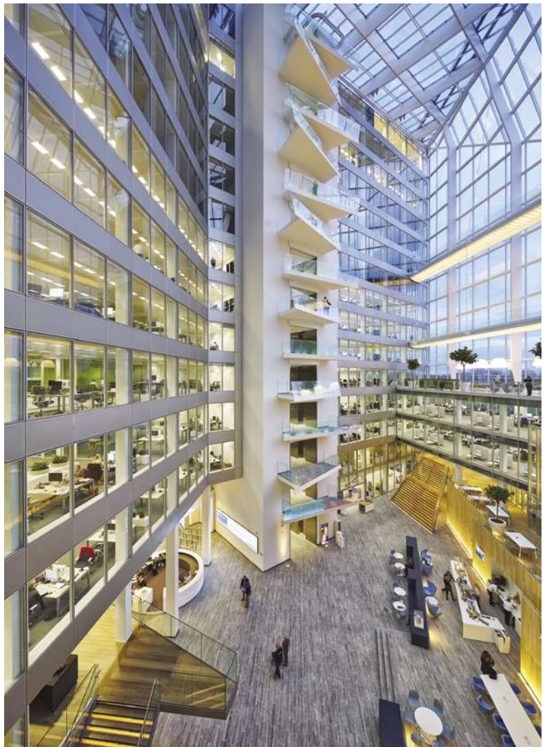
L'atrium de The Edge. Ouvert sur le nord, il apporte de la lumière à tous les étages et permet de réguler la chaleur. © Ronald Tilleman
