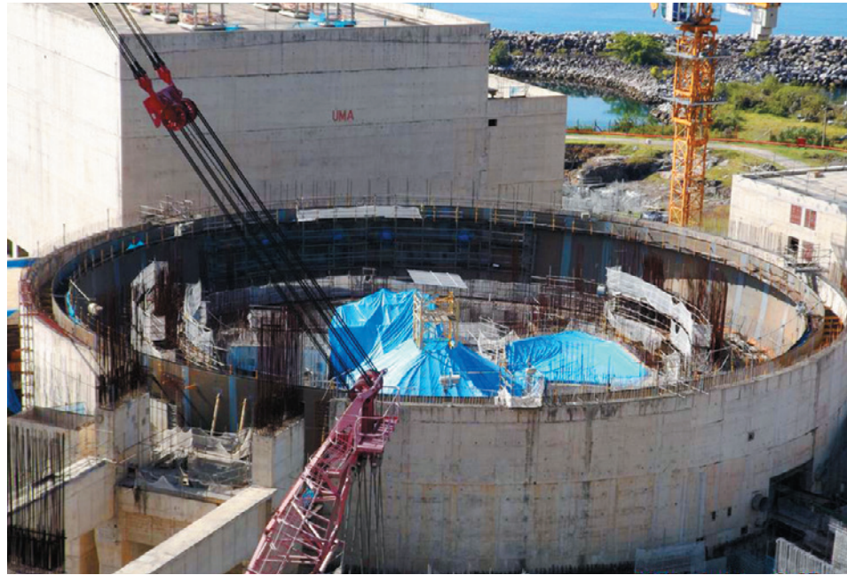
Angra 3 construction site in 2017 (Photo by Divulgação PAC/Agência Brasil)
