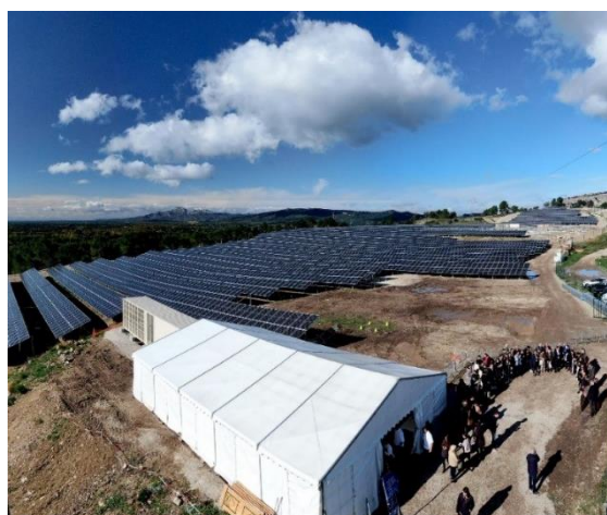
Parc solaire de Talagard le 8 novembre 2019 situé à Salon de Provence (13) - 5 MWc. Copyright Voltalia. Placés sur un espace inexploité, les 12 796 panneaux solaires alimentent la consommation de 6 535 habitants
