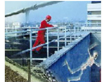
Edge Protection Railings
