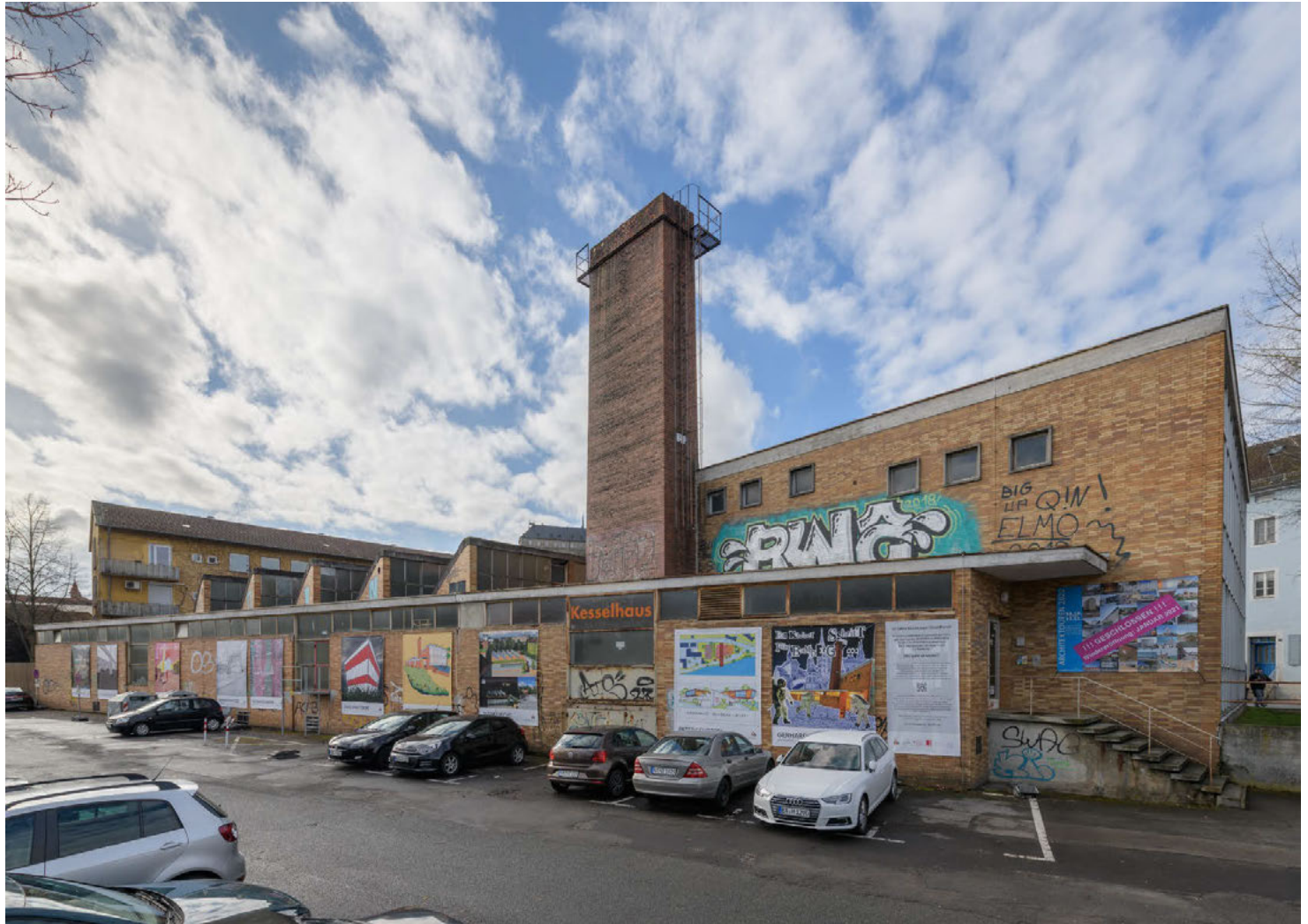
Kesselhaus Bamberg - 2021 Foto: Gerhard Schlötzer
