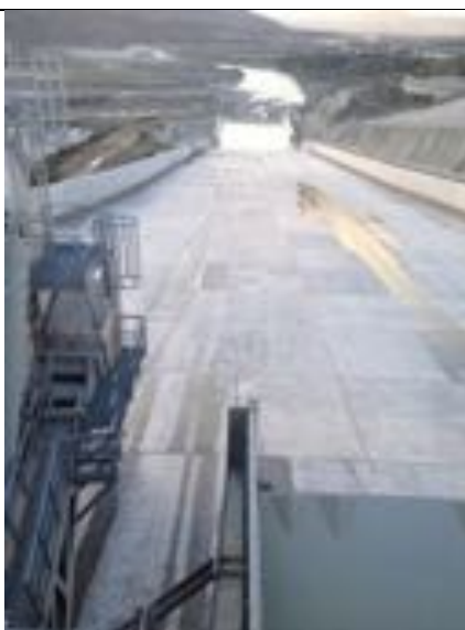
Photo 14. I-5 Banjë spillway
