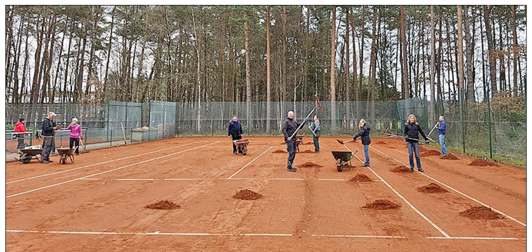
Fleißige Helfer in Aktion. Sie machten die Tennisanlage des TSV Neuenkirchen fit für die neue Saison.
