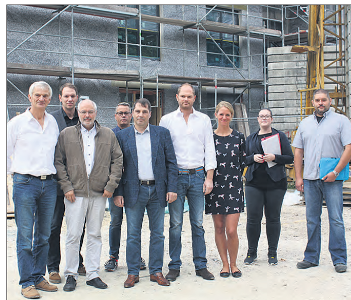
Besuch auf der Baustelle: (v.l.) Wolfgang Cassebaum und Olaf Hornbostel (beide AWS), Dr. Frederick J. Phillips, Ingo Zillmann (AWS), Dr. Stephan B. Cihal, Dr. Benjamin Rebhan, Sophie Rebhan, Jessica Ward (AWS) und Adrian Ptaszynski, bauleitender Architekt.
