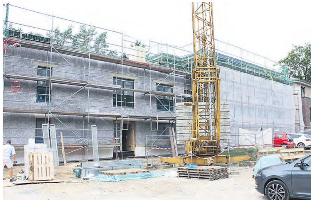
Im zweiten Ärztehaus der AWS im Oeninger Weg hat jetzt der Innenausbau begonnen.
