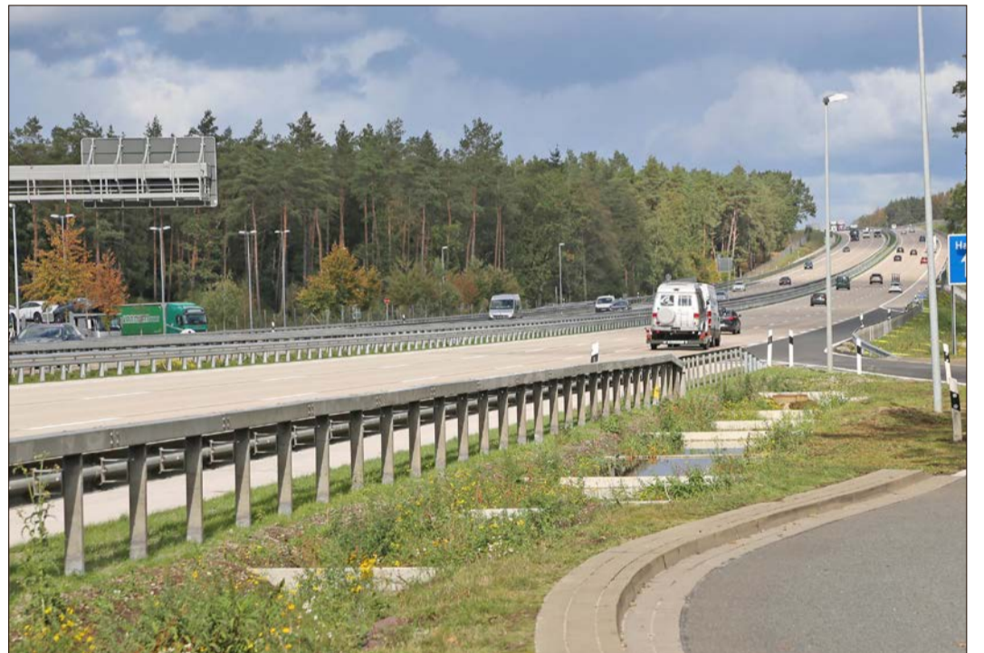
Zwischen Walsroder Dreieck und Bad Fallingbostal ist die A 7 jetzt auf sechs Spuren ausgebaut. Fotos: mwi
