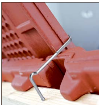
Metall-Klammern fixieren die Dachpfannen
