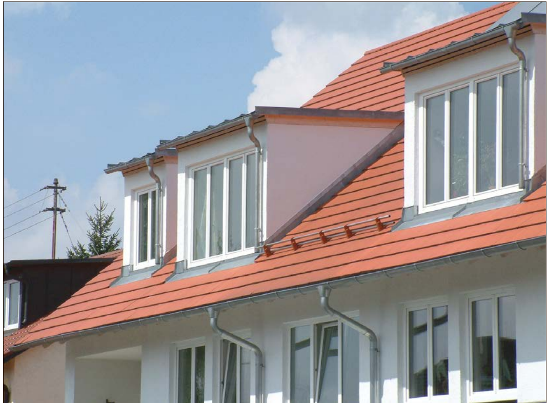
Dachdecker in der Planungsphase einbinden: Mit Gauben wird aus dem Dach-Speicher eine lichtdurchflutete Wohnung.
