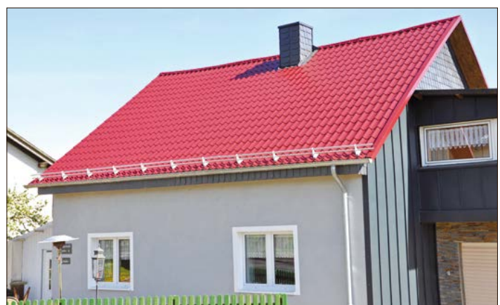
Mit Metalldachplatten lassen sich alte Bitumen- oder Asbestdächer effektiv sanieren.
