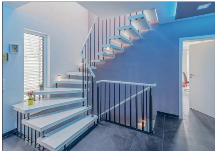
Die freitragende Treppe scheint beinahe im Raum zu schweben. Das Stufenmaterial ist sehr widerstandsfähig und pflegeleicht und zeichnet sich durch ein besonders attraktives Design aus.
