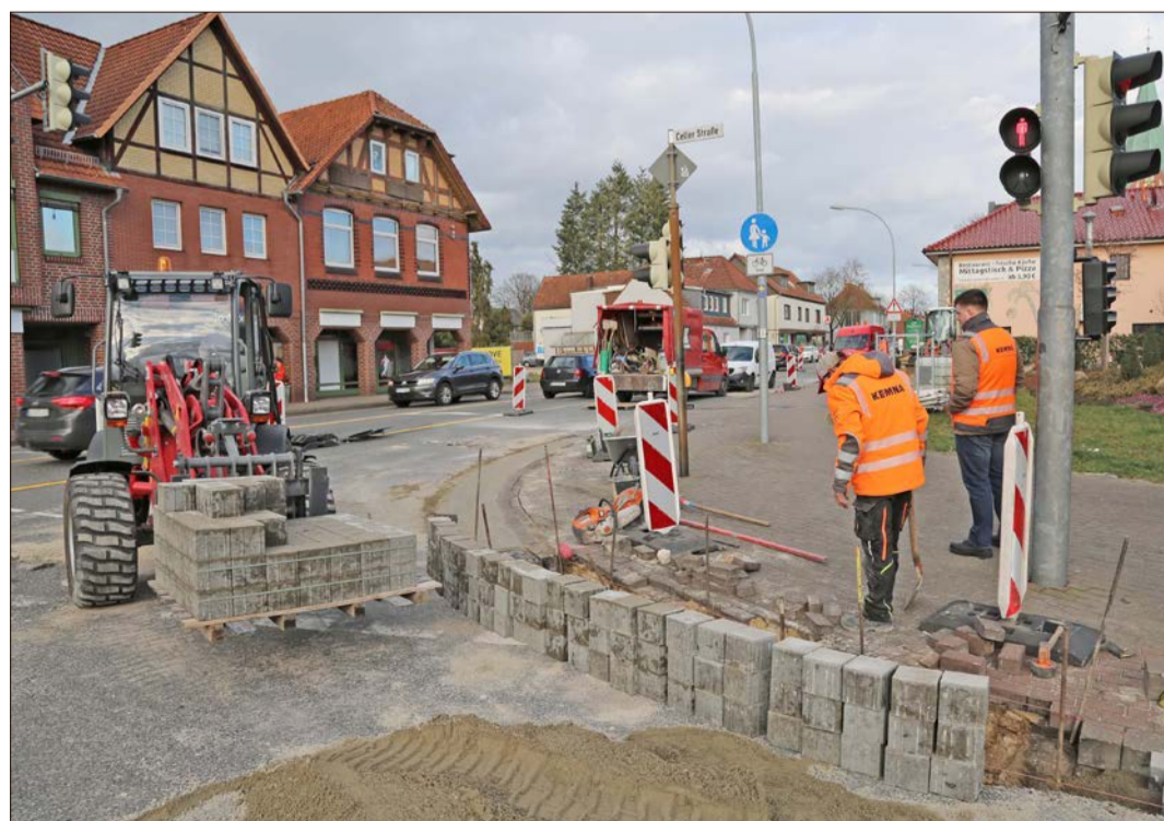
An der Kreuzung Krauls Eck haben die Bauarbeiten begonnen. Die Teams arbeiten sich nun die Lüneburger Straße hinaus vor.
