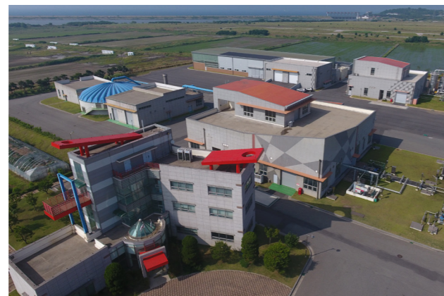
당진시 가축분뇨지역단위통합센터_95 m 3 /d
