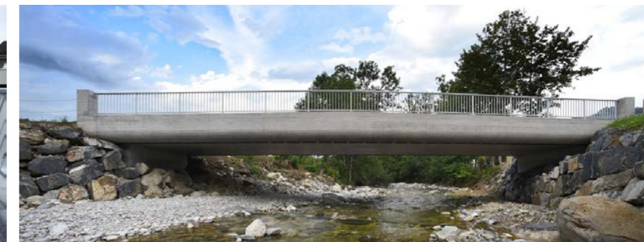
Die neue Brücke (Bilder: H9/Hans Ulrich Gantenbein/dav.ch)
