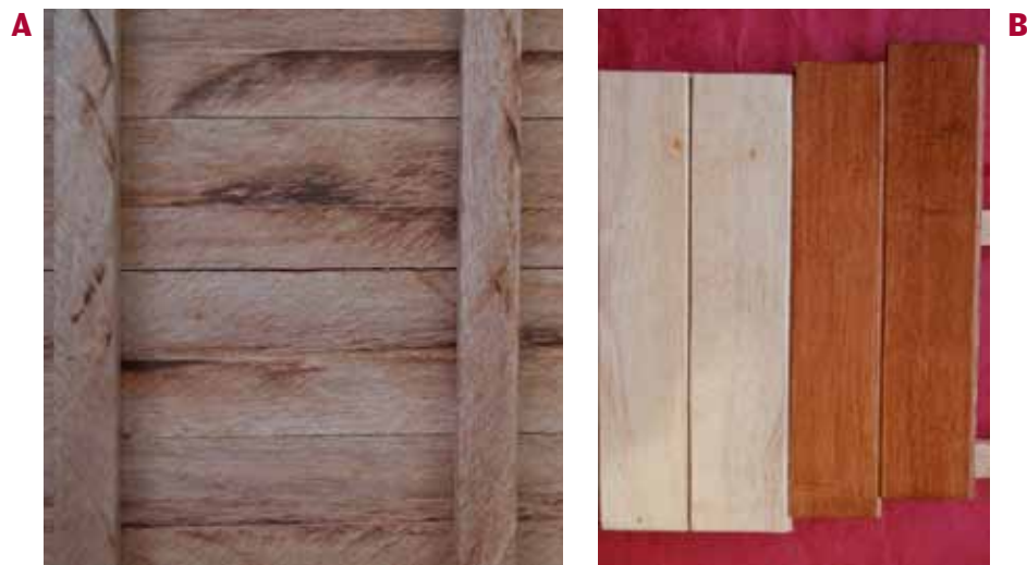
Figura 24. Ensamble industrial. A: Vista interior. B: Vista exterior con aplicaciones de barniz natural y entintado.
