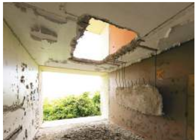
Trémie créée dans la dalle d'une chambre au nord
