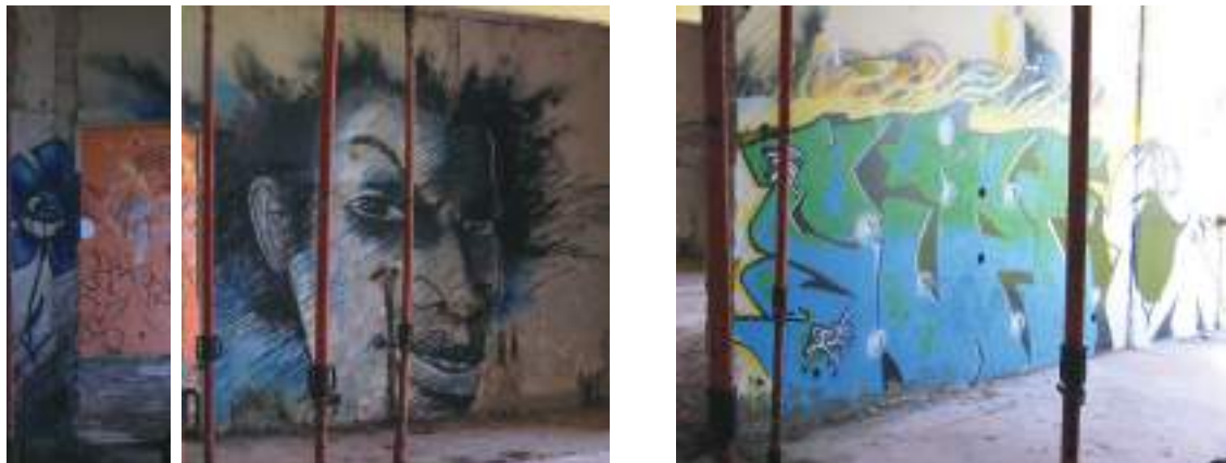
2 e étage : mur au nord, face à l'escalier
