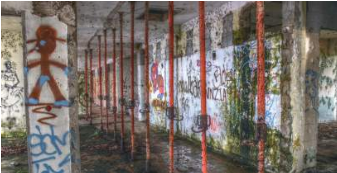
1 er étage : hall en haut de l'escalier
