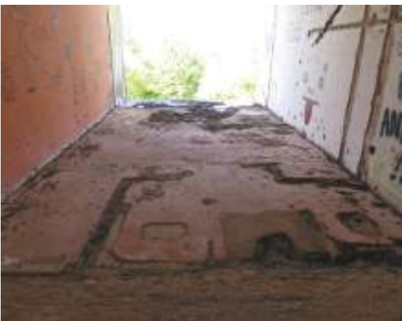
1 er étage : traces des anciennes cloisons de salle de bain dans toutes les chambres
