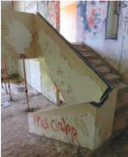
Escalier entre le 1 er et le 2 e étage
