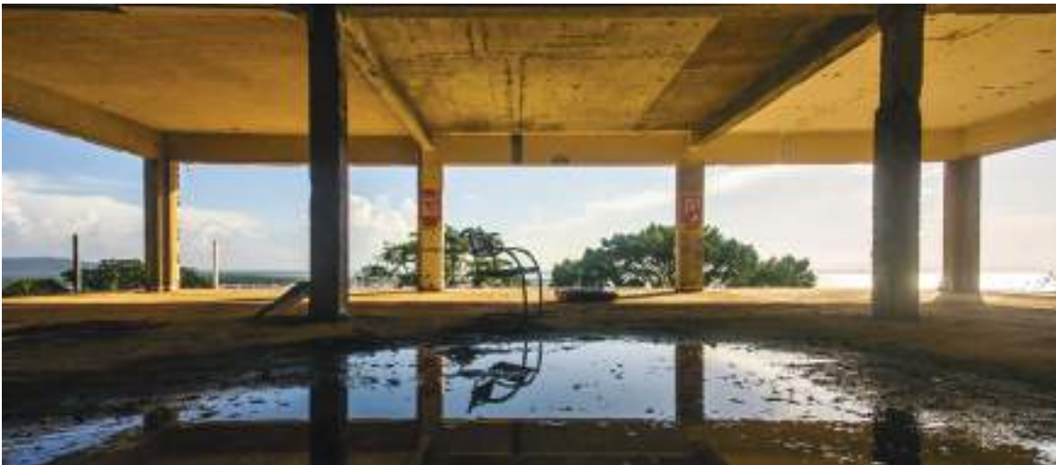
Vue depuis le restaurant panoramique au 2° étage
