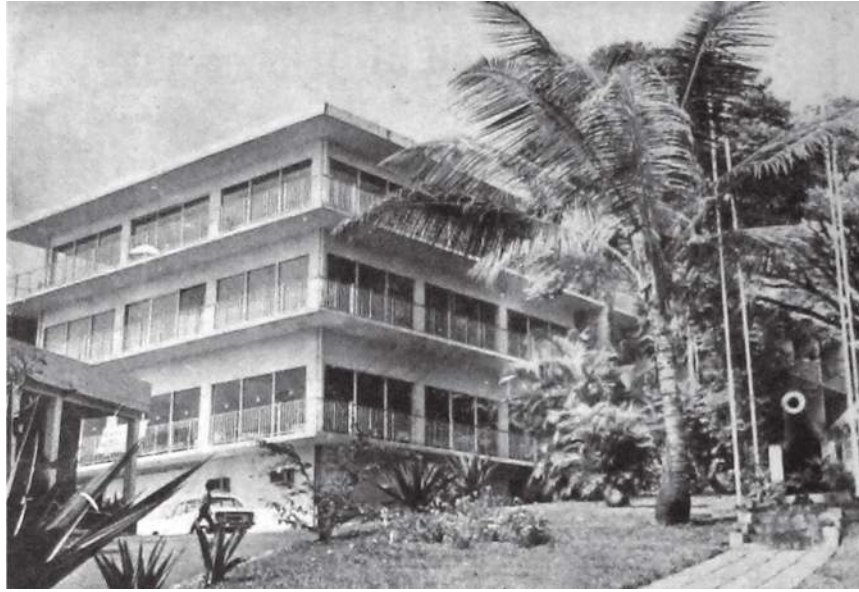
Vue depuis le chemin d'accès / angle sud-ouest
