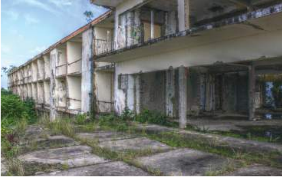
Façade nord côté mer Chambres à gauche, restaurant panoramique à droite
