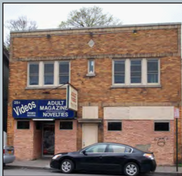
490 Monroe Ave, 2014. (Photo - G/FLRPC)
