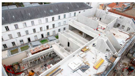
Vue du chantier d'extension du musée Bonnat-Helleu de Bayonne, Pyrénées-Atlantiques.
