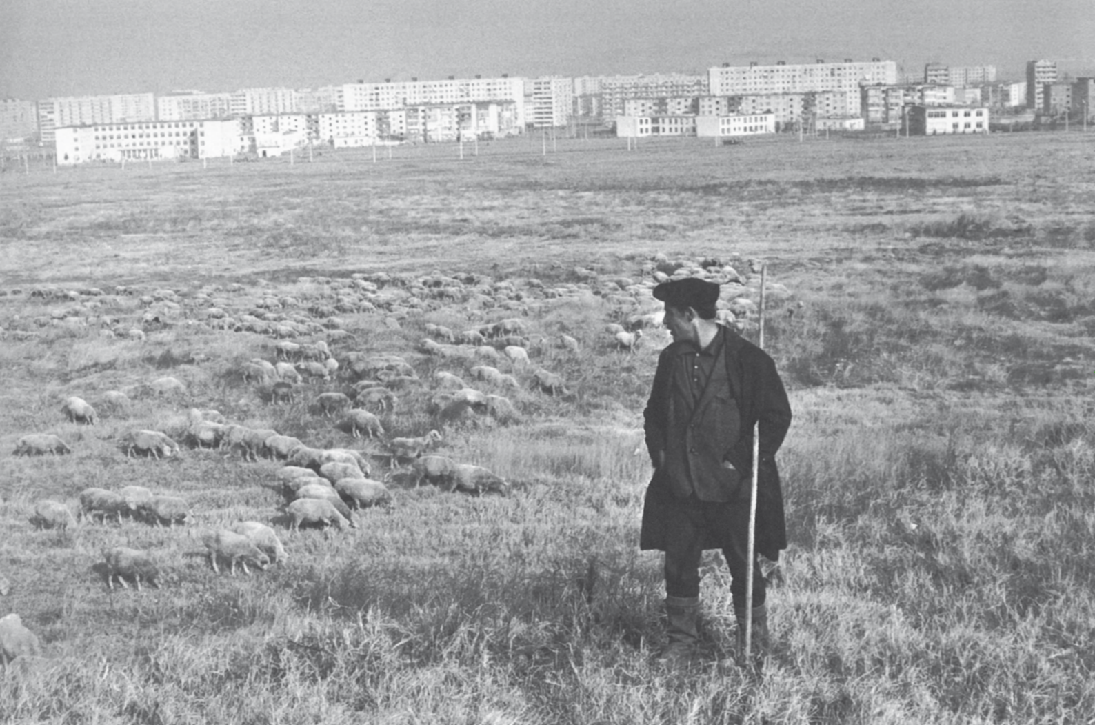
Wohnbauten in Rustawi, 1972
