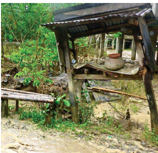
Überschwemmung in Rakhine.
