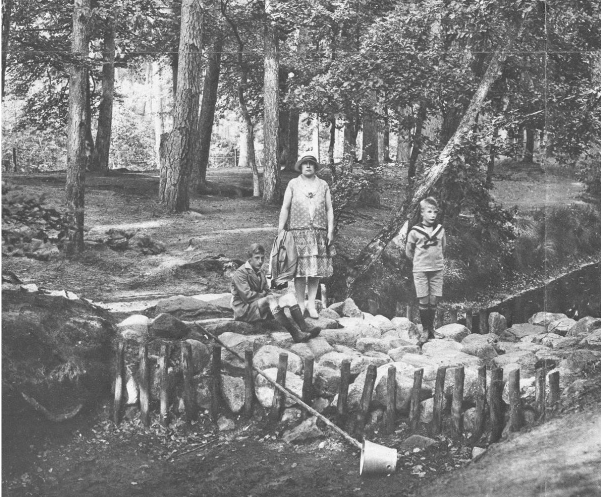
De Keienbrug in 1929. De brug is in 1919 hersteld (spelende kinderen hadden veel stenen laten weggrollen) door aan weerskanten houten palen aan te brengen.
