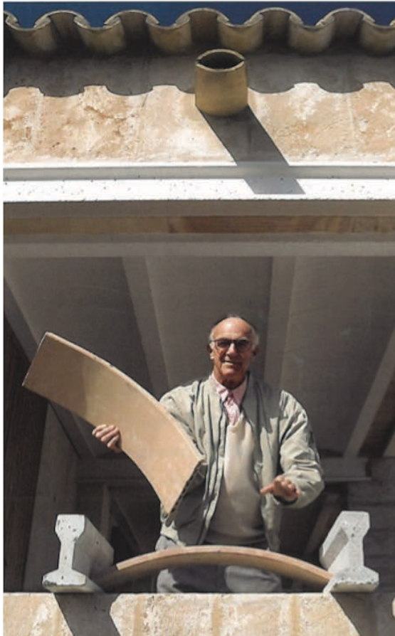
4 - Jørn Utzon demonstriert die Fügung der Tonplatten und H-Betonträger
