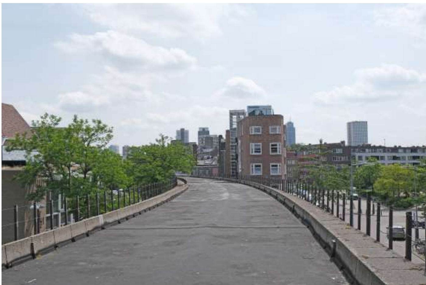
25 Huidige situatie: dakaanzicht in het noordelijk deel. Spoorpunt
