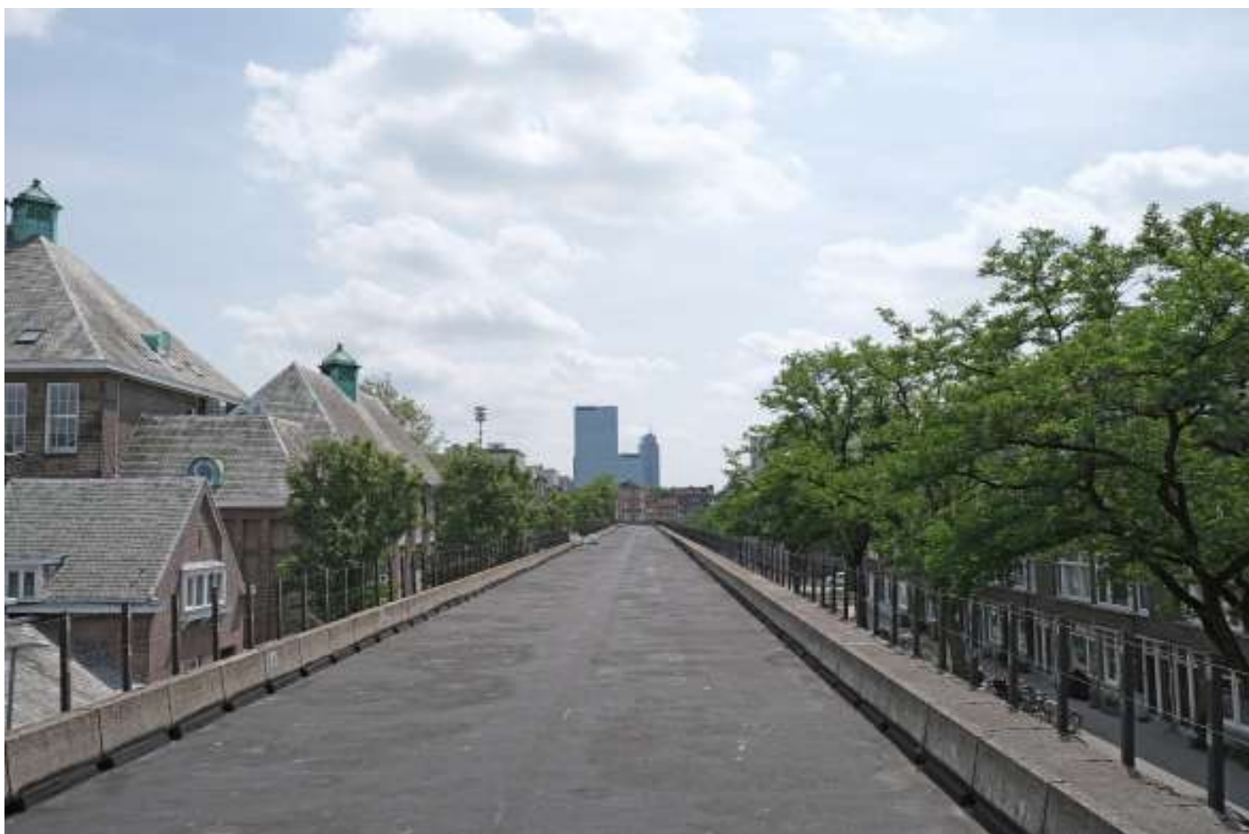
24 Huidige situatie: dakaanzicht in het noordelijk deel Bergpolder richting centrum
