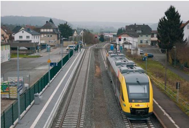
*In Reiskirchen wurde wegen des Umbaus des Stellwerks ein zweiter Außenbahnsteig errichtet (links im Bild). Der Bahnhof ist nicht mehr mit Stellwerkpersonal besetzt, sondern wird von Mücke aus gesteuert*
