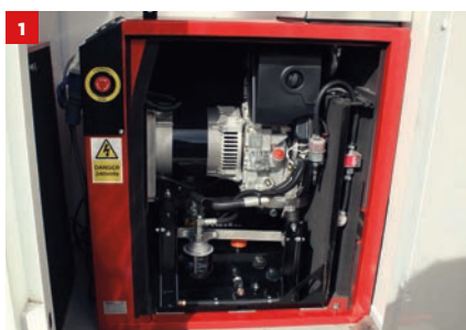
1) Remove Generator Door
