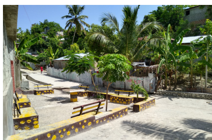
Construction de voies piétonnes et placettes à Jérémie Projet Care Haiti
