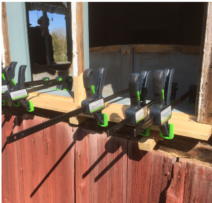
Lagning av karm pågår.
