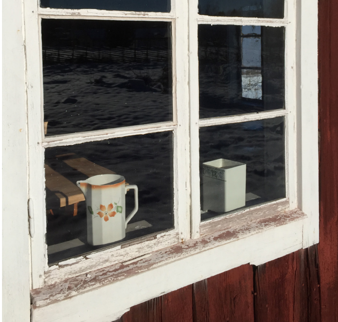
Två fönsterbågar som ska plockas ut och renoveras.
