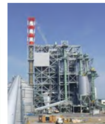
MPM王子エコエネルギーのバイオマスボイラ
