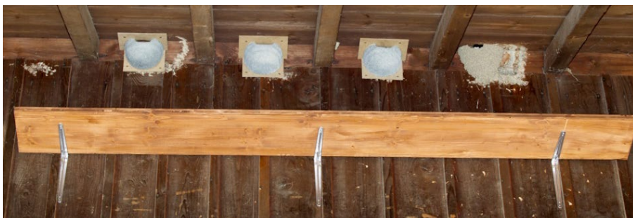
Exemple d'installation de planchette anti-salissures sous des nids naturels et artificiels photo Christian Fosserat
