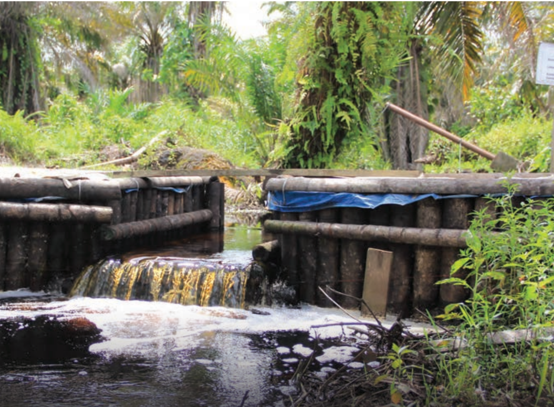
Sekat kanal di ekosistem gambut Kabupaten Tapanuli Selatan, Provinsi Sumatra Utara (Foto: © Konservasi Indonesia/Aristya Tri Rahayu)
