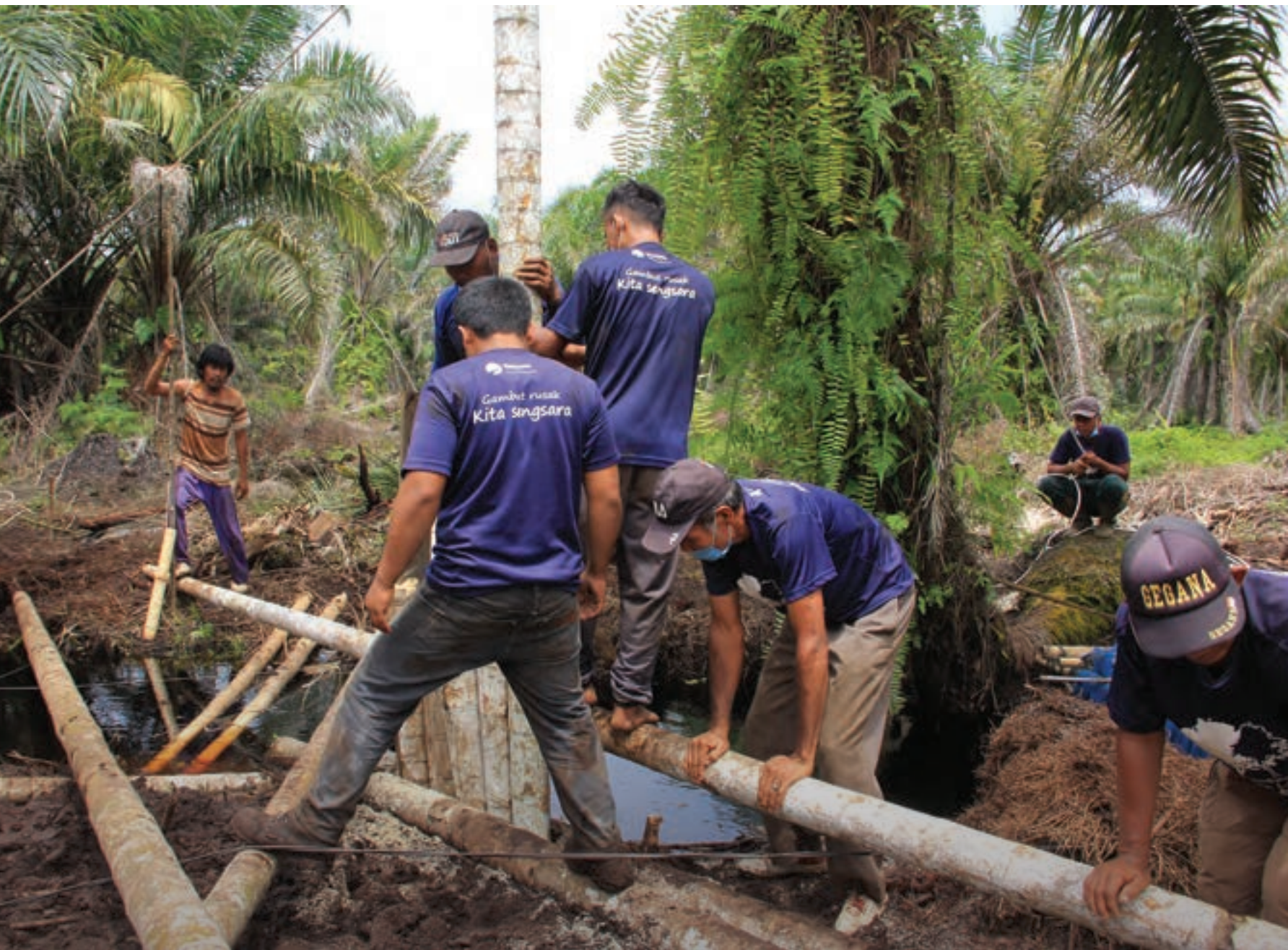
Membangun sekat kanal ekosistem gambut di Kabupaten Tapanuli Selatan, Provinsi Sumatra Utara (Foto: © Konservasi Indonesia)
