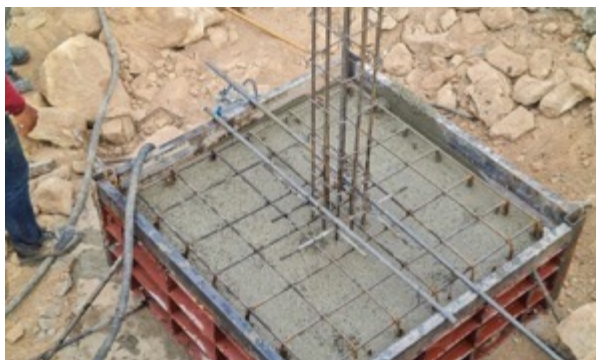
Beton armovaný ocelovými tyčemi (železobeton)
