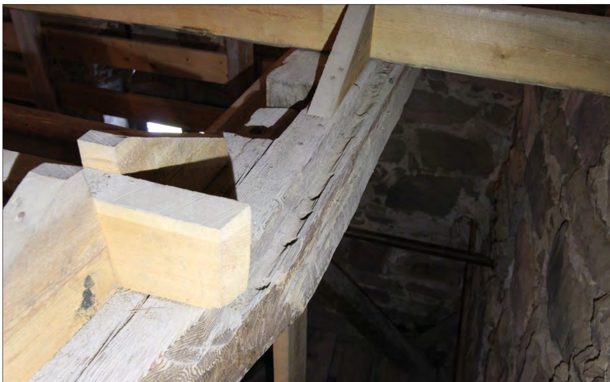
Figur 13. Över klockorna och närmast östra väggen finns ett väggstimmer upplagt i gluggar mellan norra och södra murverken. Delar har buggits bort för att ge plats åt en trappa. Timret är bilat på samtliga sidor. Det finns ett spår eller slags fals utmed ena bredsidan och på motsatt bredsida finns två laxknutar. Falsens funktion diskuterades och teorier kring om den gjorts för en takfotsbräda, anfang för tunnvalv eller fals för innertak framfördes. Verktygsspåren visar att spåret/falsen, med största sannolikhet, har gjorts med stocken på plats i väggen. Laxknutarna förefaller också ha gjorts i upptimrad vägg varför teorin om takfotsbrädan inte verkar trolig. Navare har använts för att borra genom fibrer och underlätta urbuggningen. Eventuellt har någon form av krokjärn använts för att karva ut formen.
