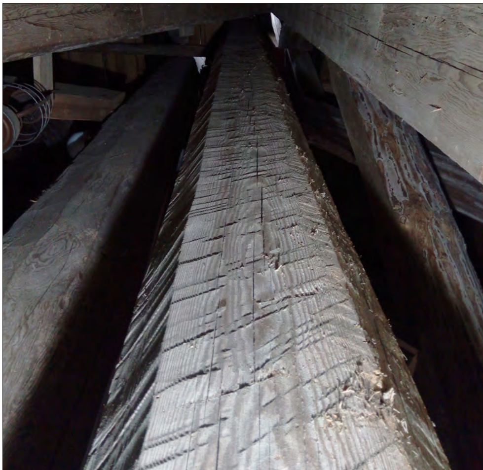
Figur 26. Hjärtstocken omringad av sekundära förstärkningar. Foto från bottenvåningen och uppåt av Bengt Bygdén.
