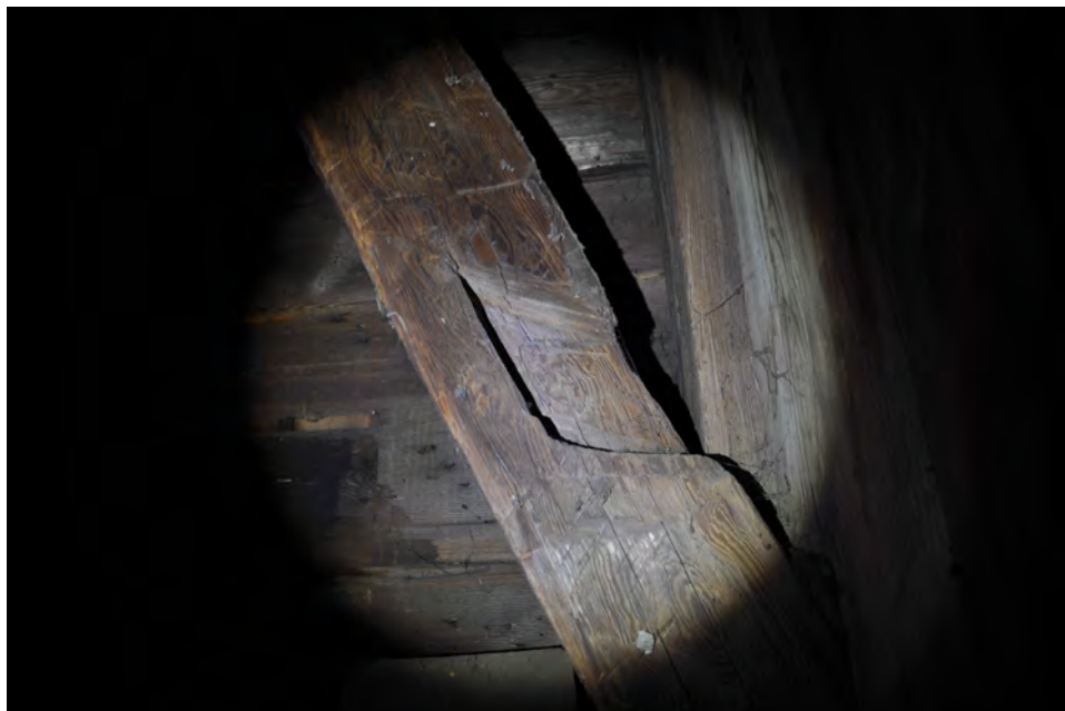
Knutpunkt för diagonal sträva med låsande laxstjärt.
