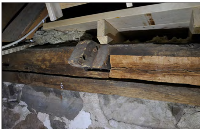
Figur 8. Remstyckena har en utvändig fals för en tidigare takfotsbräda. Den utstickande delen av stickbjälken/bindbjälken har en lutande undersida som visar på att takfotsbrädan varit uppvinklad. Bilden visar korets remstycke fotat från sakristian. Korets och långhuset remstycken är likadana. Foto Daniel Eriksson.
