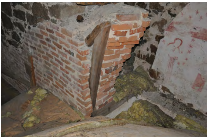
Bilden till vänster visar rest av remstycke, valvbåge och högben i kyrkans nordöstra del. Foto: Daniel Eriksson.
