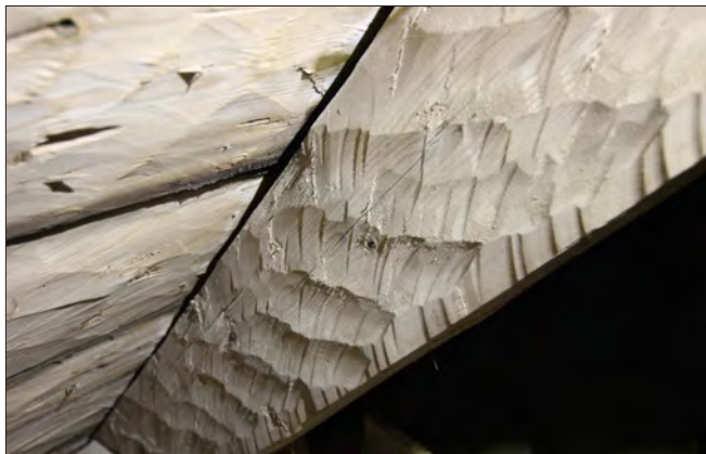
Figur 13. Högben som först sprättbuggats i längsgående band och sedan har man tält en gång till, diagonalt över fiberriktningen.
