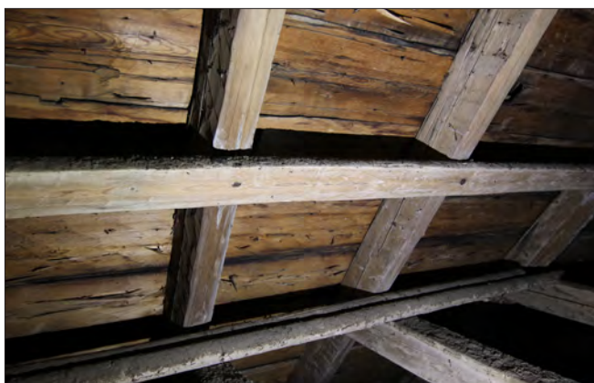
Figur 8. Längdförstyvningar finns från resningen av taklaget. De är omkring 9,60 meter långa, 3,5 cm böga och 12 cm breda.
