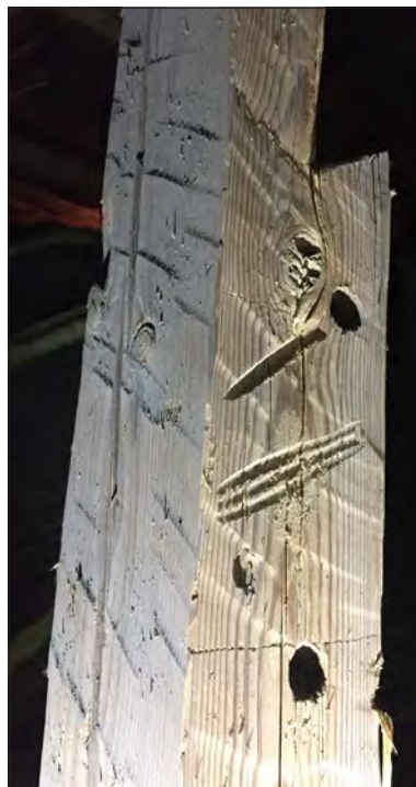
Figur 29. I takstol nr 1 från öster, södra sidan, finns märken efter gröppjärn ritsar och dymlingshål i stödbenet. I och med stödbenets placering nära in på murverket dras slutsatsen att märkningen måste ha gjorts innan takstolen monterades på plats. Foto Daniel Eriksson.
