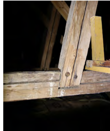
Husad knut med dymling och spik, östra delen av långhuset.
