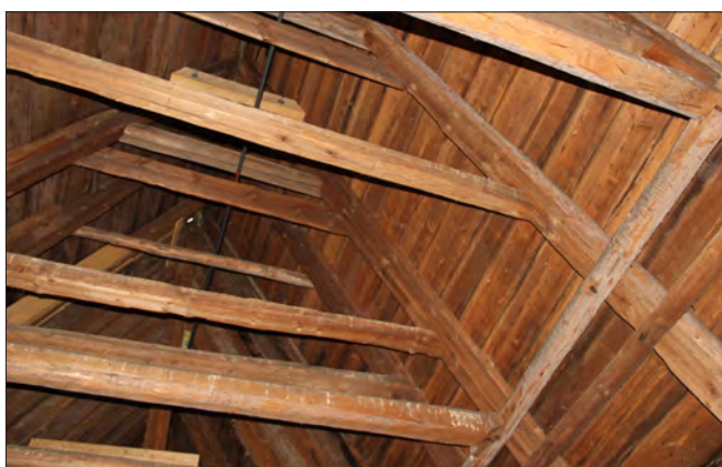
Figur 8. Övre delen av taklaget i östra delen av långhuset.
