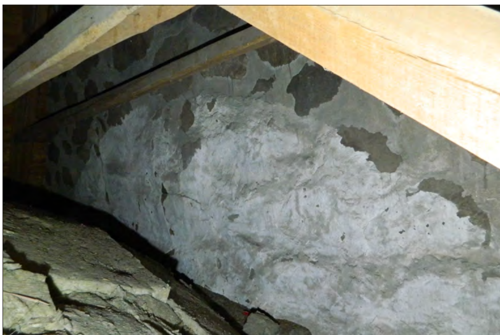
Figur 15. Putsad välvd yta i korgaveln. Foto Bengt Bygdén.
