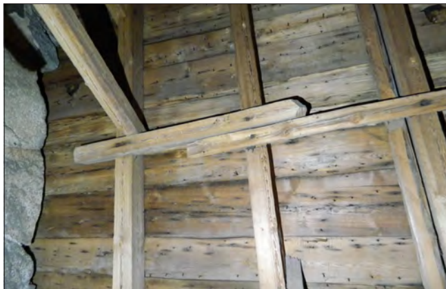
Figur 10. Monteringsreglar i västra delen av långhuset, norra takfallet. Foto Bengt Bygdén.
