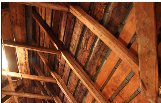
Figur 8. Högben och övre banbjälkar samt äldre och yngre taktrö.
