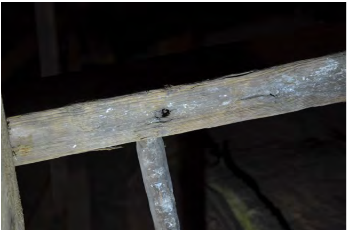
Spikhål med avtryck från spikskallen, kanske för att stegen varit fast monterad.
