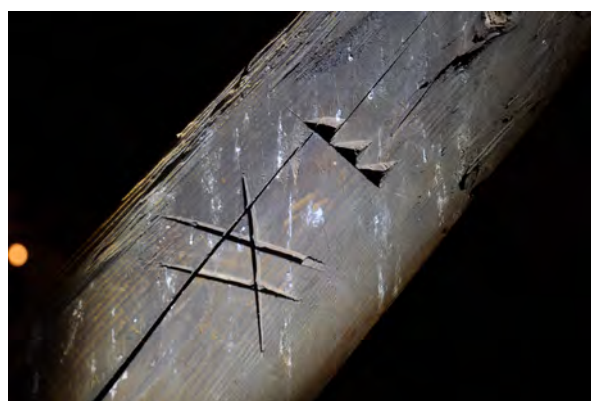
Fotot till vänster visar stödbenets inknutning i högbenet, utfört med nacke och fasning. Dymlingen är fint täljd. Fotot ovan visar exempel på timmermansmärkning. Foton: Daniel Eriksson.
