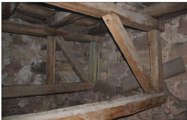
Figur 6. Medeltida delar ingår i konstruktionen under klockvåningens bjälklag.
