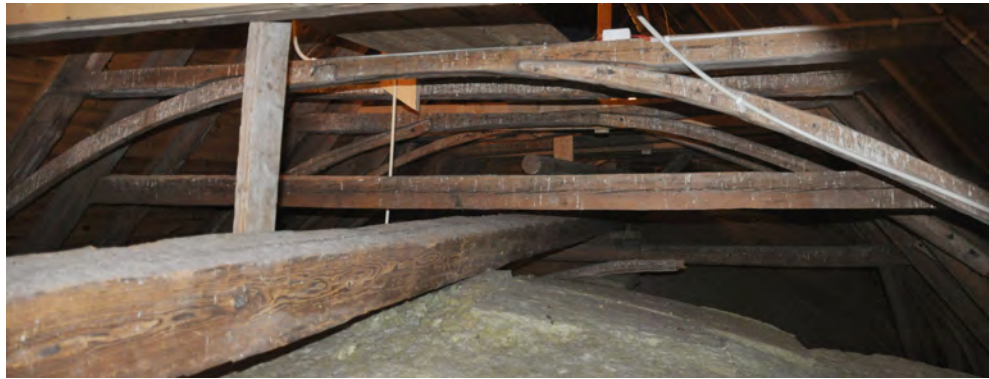
Del av takstolskonstruktionen med valvbågar. Foto: Daniel Eriksson.
