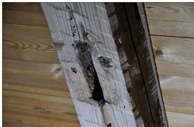
Figur 10. Urtag i högben för de före detta korsande stödbenen. Tapphålet är genomgående och låsning saknas. Tryckmärken efter stödbenet kan urskiljas. Foto Daniel Eriksson.
