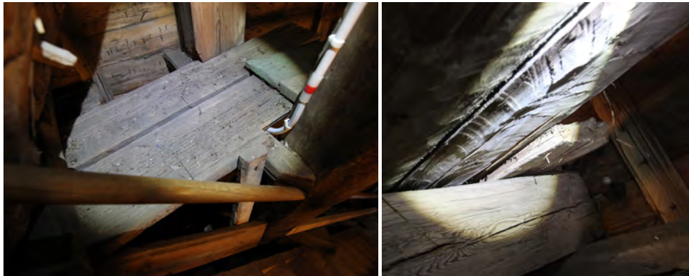
Några av golvplanken, på böger sida ovanför första trappan, är också medeltida. Till höger en detaljbild av deras undersidor och behugningen i släpljus.
