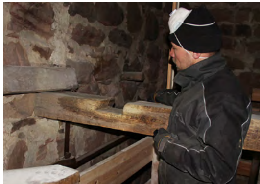
Foto till vänster, flera snedfasade urtag finns på ett timmer. Foto: Daniel Eriksson. Fotot ovan visar urtag på timrets breddsida med en rak och en sned kant. Ett likadant urtag finns i andra änden. I bild syns Daniel Eriksson.
