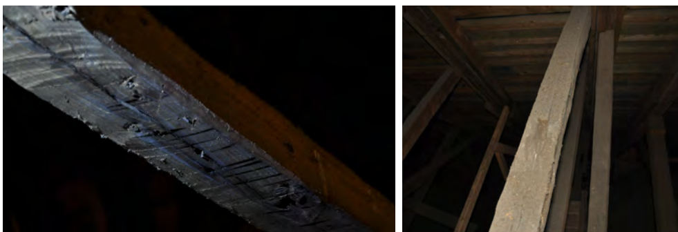
Det f.d. högbenet är spröttäljt, i end sidan syns spikbål och på andra sidan ett tapphål. Foton: Daniel Eriksson.
