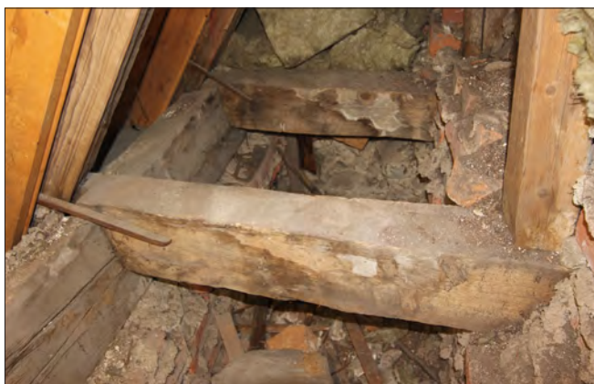
Figur 7. Stickbjälkarna utgjorde tidigare bindbjälkar i en äldre konstruktion. Bjälkarna bögs av vid valvsлагningen. Virket utgörs av skarpkantad sprättbuggen ek i såväl remstycken som stickbjälkar/bindbjälkar. Högbenen har att glidit ifrån förbindningen, därför har timmerbakar slagits i vid något tillfälle.
