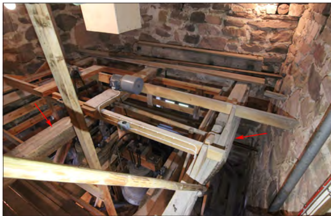
Figur 4. Två av de undersökta bjälkarna över klockorna är markerade med röda pilar. Foto från sydöstra hörnet av tornet.
