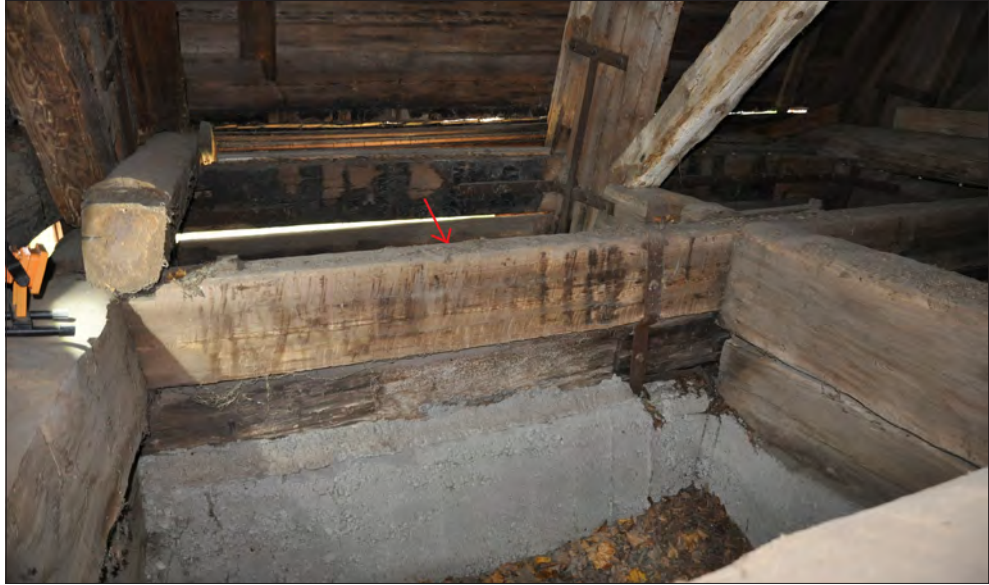
Figur 5. Syllvirke i befintlig och medeltida konstruktion markerad med röd pil. Foto Daniel Eriksson.
