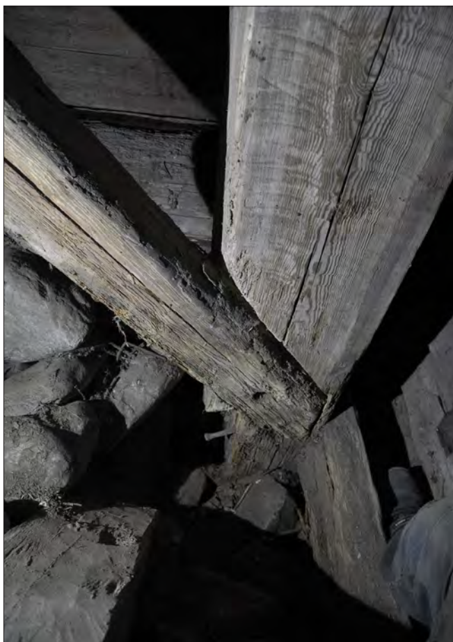
Figur 23. Sydöstra hörnets nedre del, krysssträva och hörnben. Foto Daniel Eriksson.
