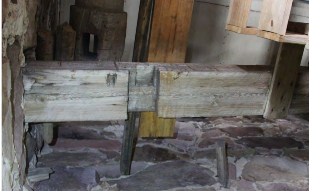
En av de återanvända timmerstockarna i Malung kyrkas torn. Timret har sprätthuggna och skavda ytor.
