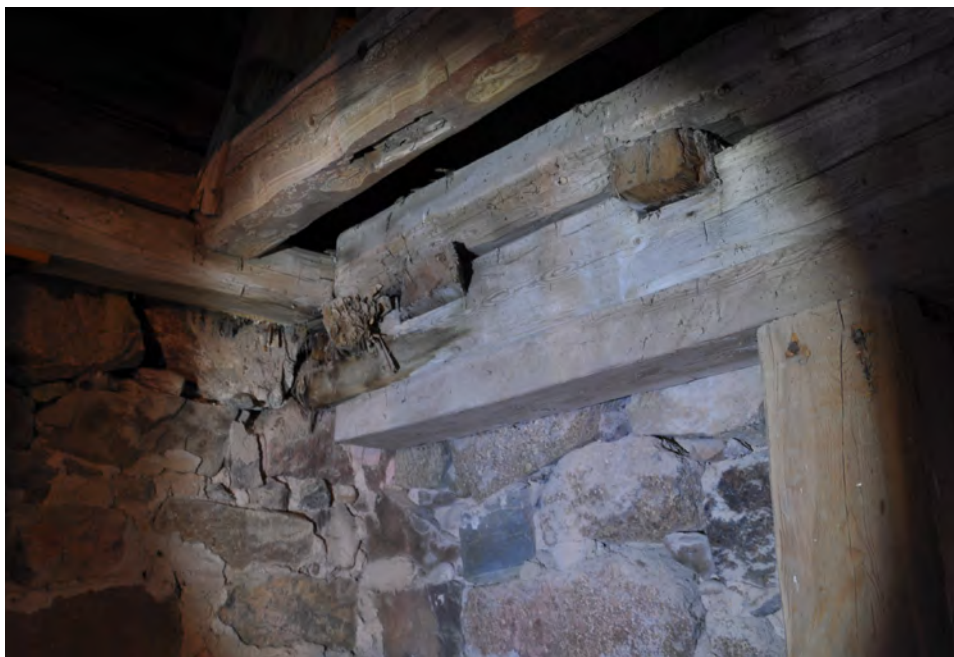
Del av konstruktion i tornet som indikerar att en tornbuv funnits tidigare. Foto: Daniel Eriksson
