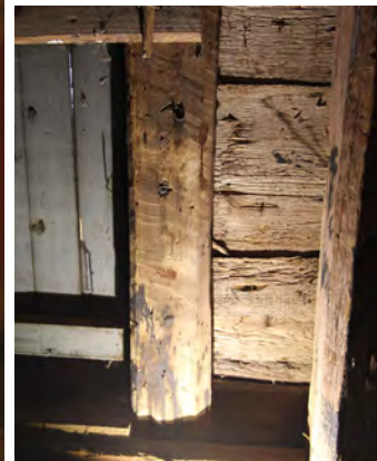
Stolpen närmst panelen mellan ljudluckorna är en återanvänd medeltida sprättäljd bjälke (t.v.). Ljudluckornas foder är av återanvänt medeltida sprättäljt taktrovirke (t.h.).
