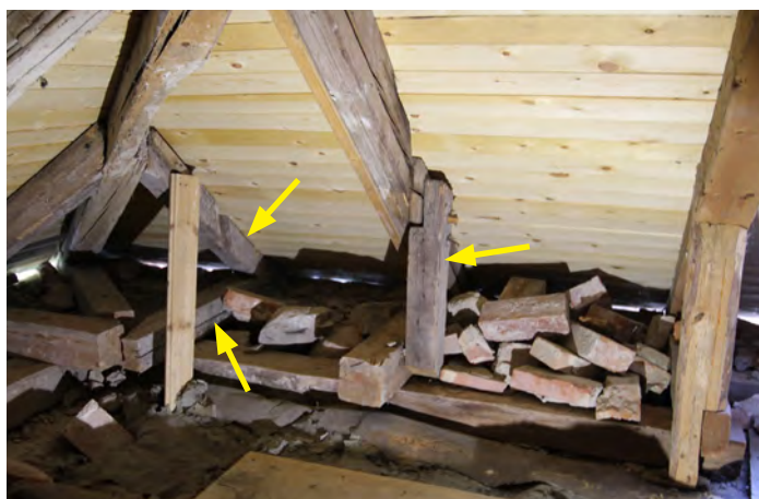
Delar som bedöms vara senmedeltida och återanvända finns i östra takfallet. De är markerade med gula pilar.
