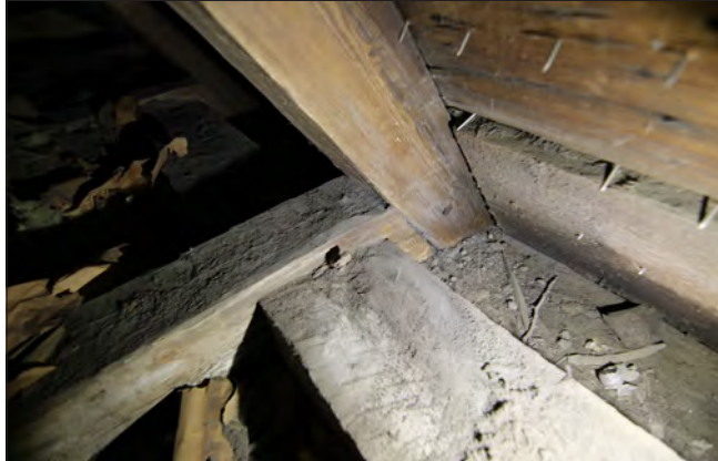
Figur 9. Möte mellan högben, stöckbjälke och yttre remstycke i långhuset.
