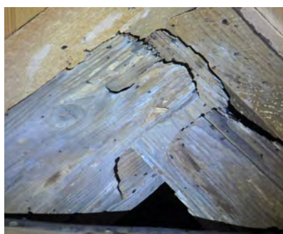
Bilden ovan visar tapphål i högenen, eventuellt efter intappade saxade stödben från en förmodad äldre konstruktion.
