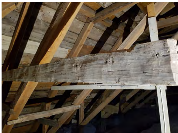
En bräda vars ena sida bearbetats med skave, uppskattningsvis 1400-1500-tal. Den sitter uppspikad på en takstol.
