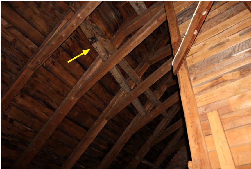
Huggna taktrobrädor upplagda över sakristians takstolar.
