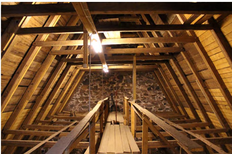
Taklag över långhusets östra del.
