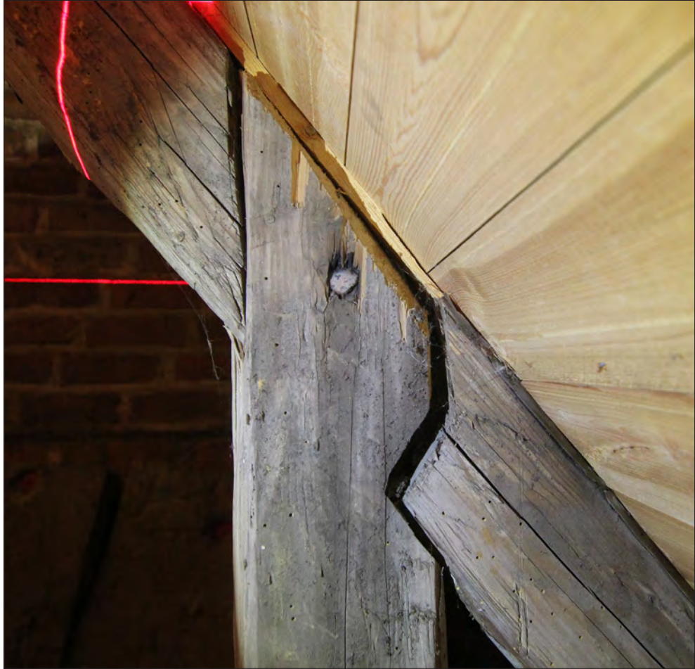
Figur 14. Badelunda kyrka. Exempel på knut med nacke som är vanlig under senare medeltid.
