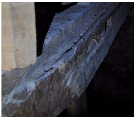
Fotot till vänster visar ett långsgående spår i timret. Man har först borrar sedan huggt rent. Det som troligen varit undersida har en konkav yta. Bilden ovan visar ett rektangulärt hål med dymlingen kvar. Foton: Daniel Eriksson.
