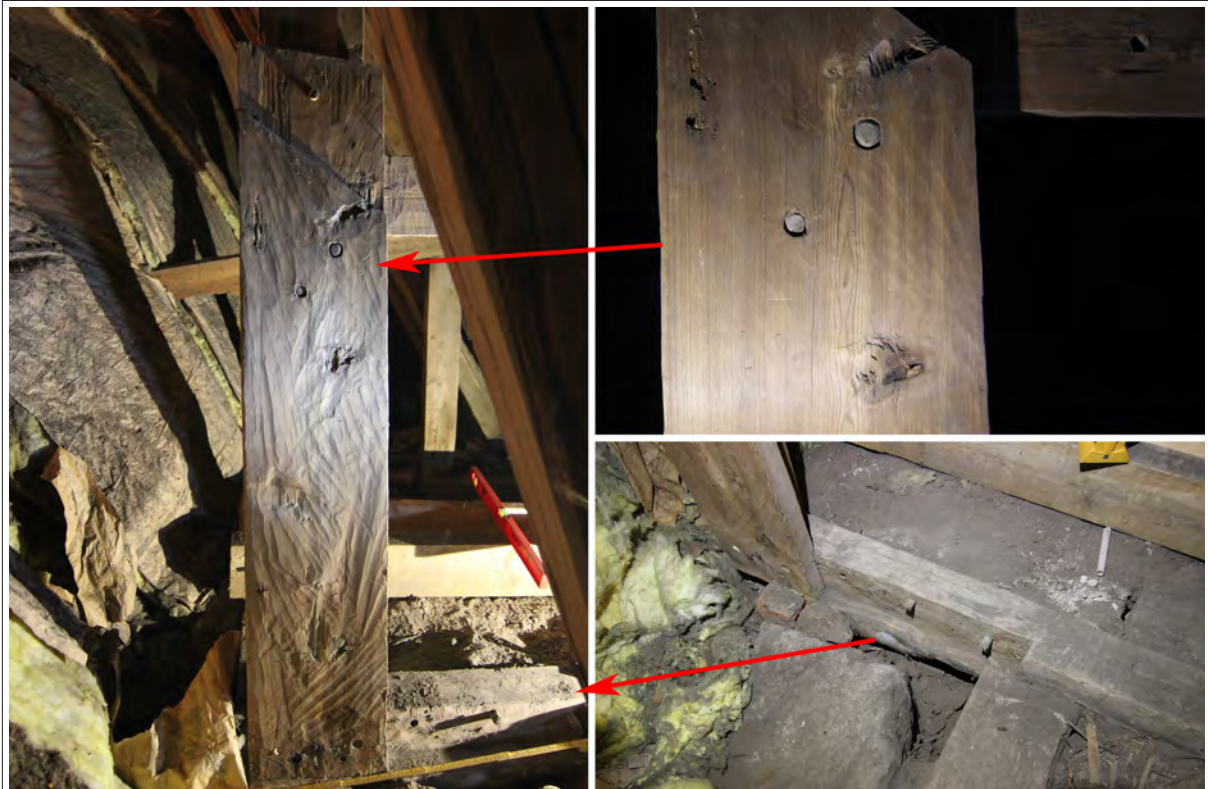
Figur 12. Delar av takstol nr 14, södra sidan, sedd från väster. Plankan som är fäst på takstolen har bearbetats med skave. Det står på en fals i stickehjälken och på bilden längst ner till höger syns att det funnits plats för ytterligare två stycken. Högst uppe till höger syns små trädymlingar med fasade kanter i linje med plankans yta.
