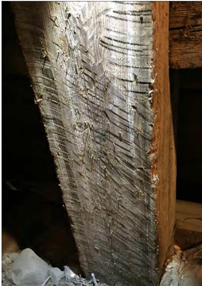
Figur 25. Sprättthuggning i flera parallella band på ett av stommens kraftiga ben. Foto Daniel Eriksson.
