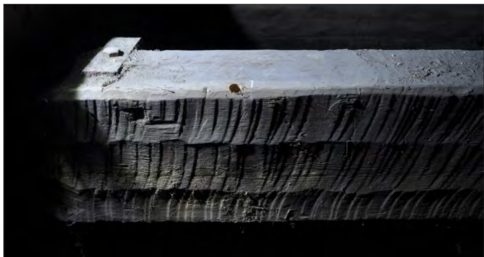
Figur 7. Torsångs klockstapel. Sprätthuggning som är mycket omsorgsfullt utförd i jämna längsgående band. Foto Daniel Eriksson.
