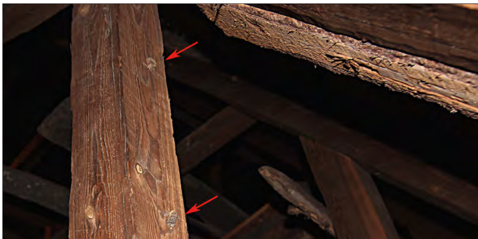
Figur 30. Röda pilar markerar tränaگلar i ett stödben, takstol nr 25, södra takfallet.
