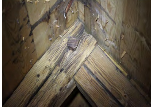
I nock är högbenen troligen sammanfogade genom tapp och slits.
