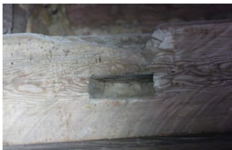
Bilden visar tapphål och ett snett urtag i en av de återanvända bjälkarna.
