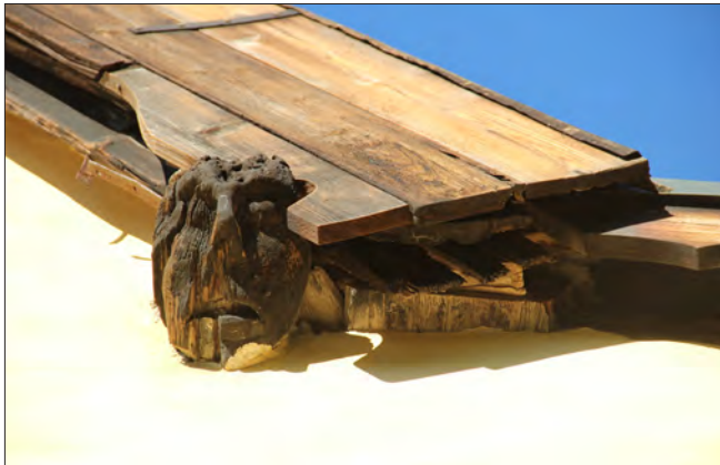
Figur 39. Högra ansiktshalvan är bättre bevarad genom ett mer skyddat läge tack vare vindskivorna.
