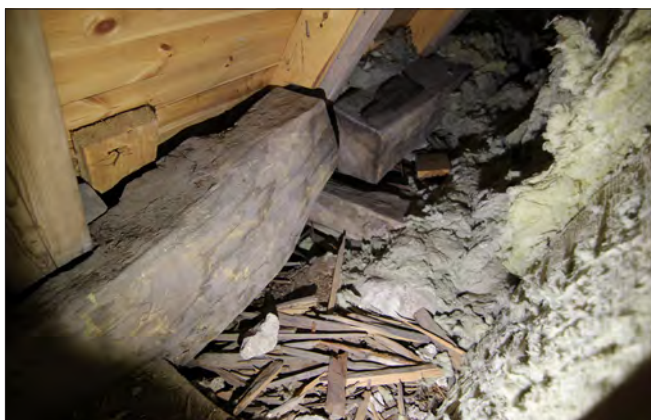
Figur 6. De två störbjälkarna möts vid takstol 17. De är grovt buggna i trapetsoid form och stammens naturliga oregelbundenhet är delvis kvar.
