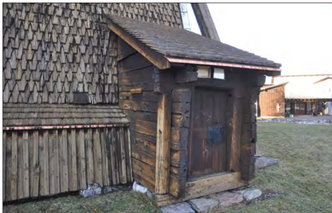
Figur 3. Entrén till klockstapeln är uppförd i skarpkantigt sprättäljt timmer. Foto Daniel Eriksson.
