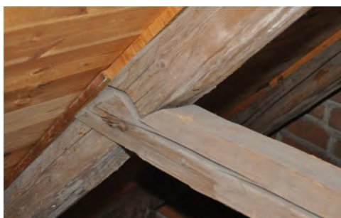
Knutning med nacke i vapenhuset från tidigt 1400-tal. Skyddsbränning på en av högenen över koret. Foton: Daniel Eriksson.
