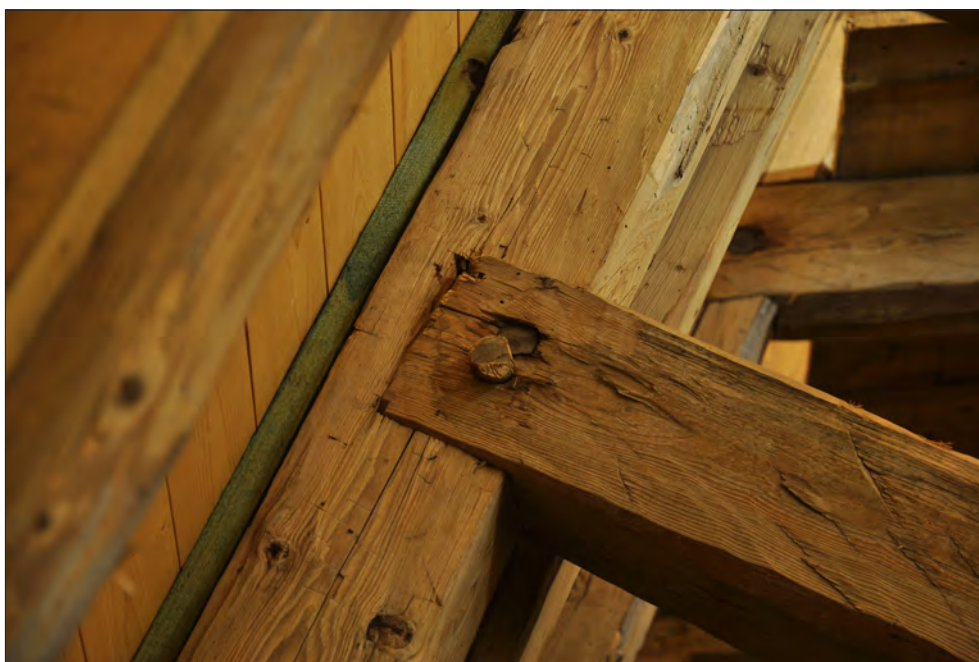
Figur 13. Ångsö kyrka. Exempel på husad knut där bladningen inte löper rakt över mötande bjälke. Ganska vanligt i tidigmedeltida taklag. Foto Daniel Eriksson.
