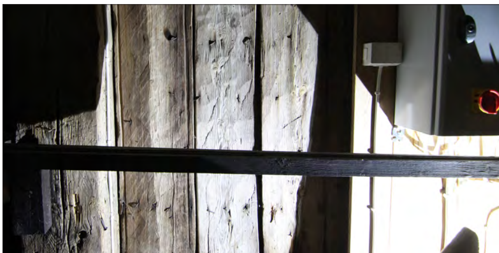
Figur 27. Bilden är tagen i klockvåningen och panelbrädan (till vänster) har medeltida behuggning. Den är sprätthuggen på båda sidorna och på insidan finns huggna, fasade ytor och vatthylade spår i ytterkanterna.
