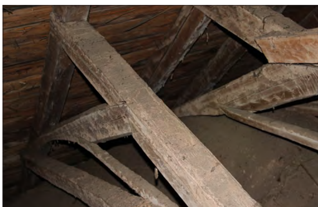
Figur 6. Del av takstolar med valvbågar, sedda snett ovanifrån.
