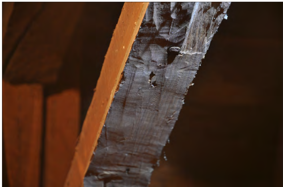
Figur 11. Sala sockenkyrka. Skaven efterlämnar ofta karaktäristiska vibrationsspår. Foto Daniel Eriksson.
