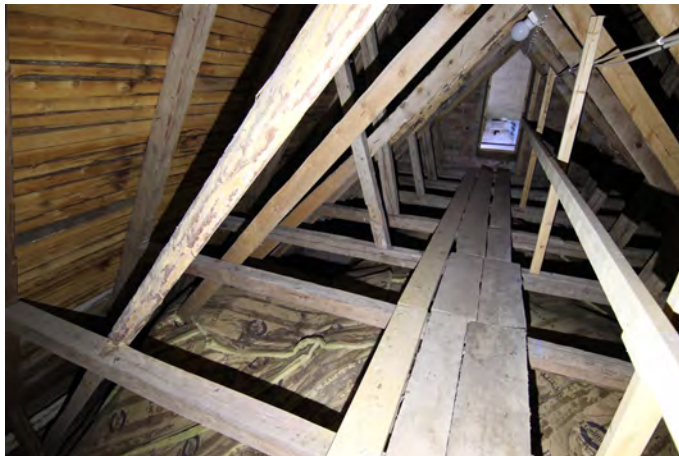
Takstolar i mellersta partiet i förgrunden. De västligaste syns i bakgrunden.
