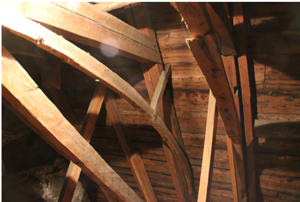
Del av taklag över Sala kyrkas långhus.
