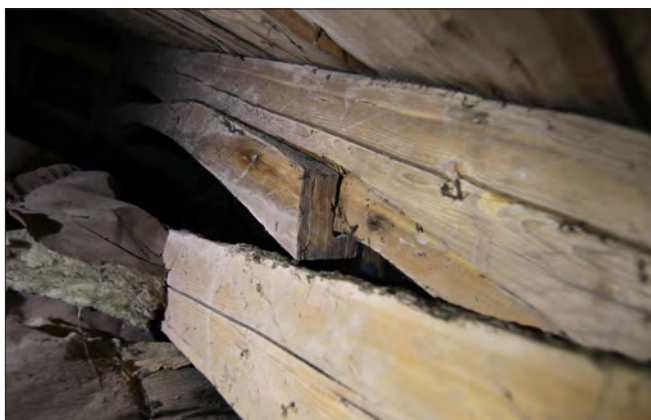
Figur 15. Valvbåge som är L-formad i genomskärning vid infattningen i hanbjälken och högbenet. Här syns också att en fals tältts ut i högbenet för inpassningen.
