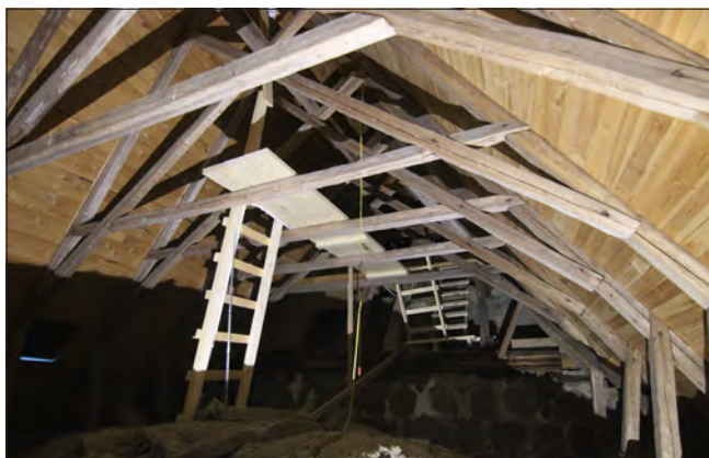
Figur 17. Takstolar över sakristian, sedda från norr.
