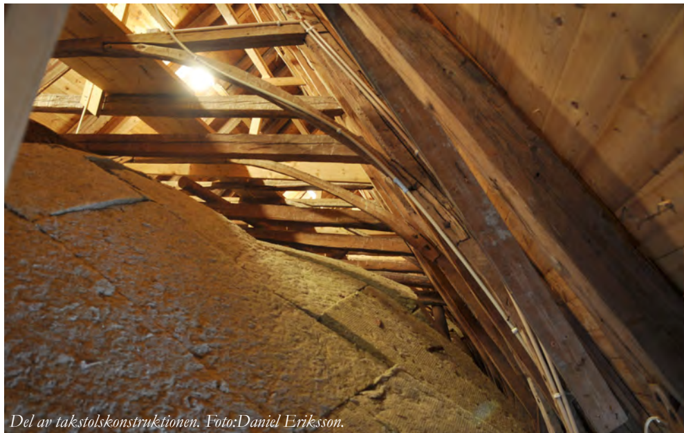
I övergången mellan högben och stödben har man i många fall att fylla ut med en liten löt eller kloss, för att fylla radien till tunnvalvet. Foto: Daniel Eriksson.
