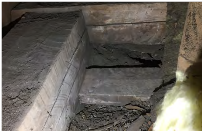
Figur 25. Yttre remstycke med intappad kortling. Foto Daniel Eriksson.
