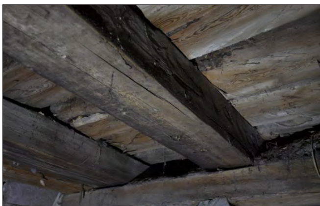
Figur 7. Medeltida timmer återanvänt i klockvåningens bjälklag.
