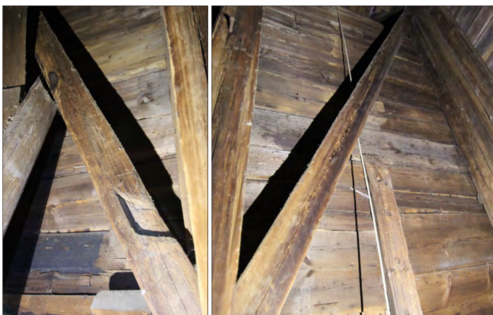
Figur 9. Snedsträvor av återanvänt väggtimmer. I den vänstra finns ett urtag i form av snedställd laxstjärt placerad nära änden.
