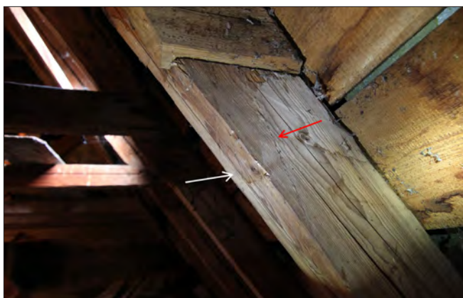
Figur 15. I högbenet på takstol nr 26, norra takfallet, syns en tunn rits (röd pil) i virket samt klämmärken och färgskjifning (vit pil) där en konstruktionsdel till treklövervalvet varit infäst.
