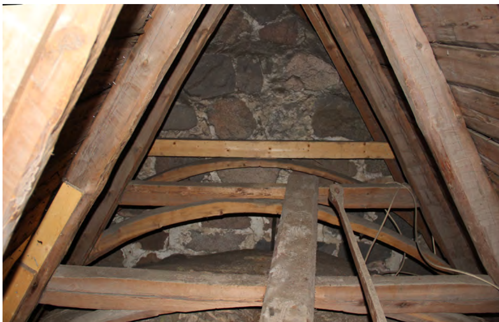
Takstolar över vapenbuset. De två bortre valvbågarna är utförda i ett stycke.
