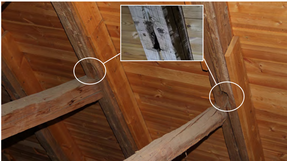
Bilden ovan visar tapphål i högenen, eventuellt efter intappade saxade stödben från en förmodad äldre konstruktion.
