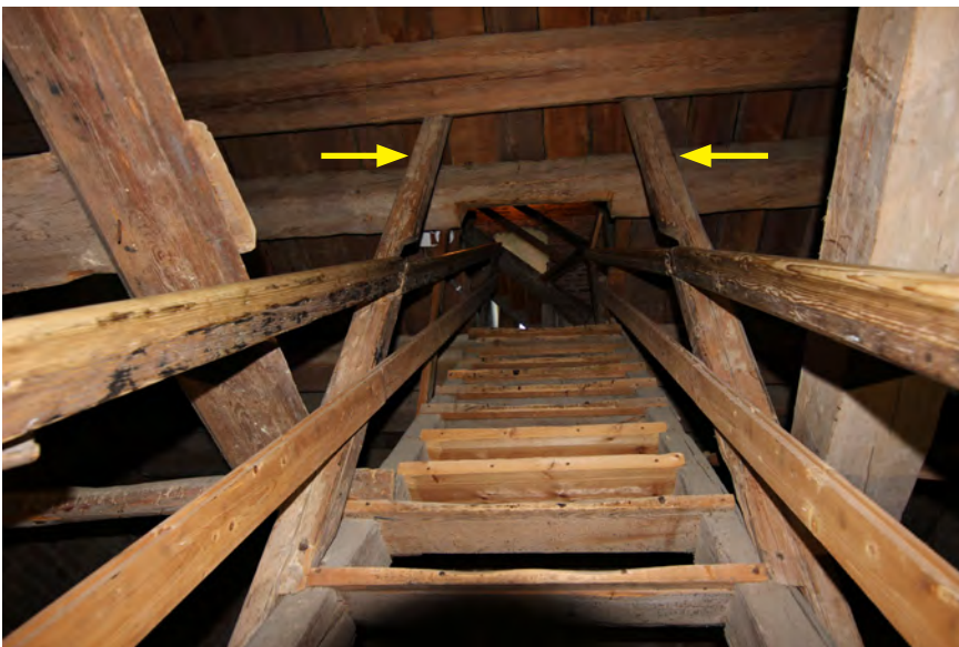
Atermvänt medeltida virke i trappen till tornet.
