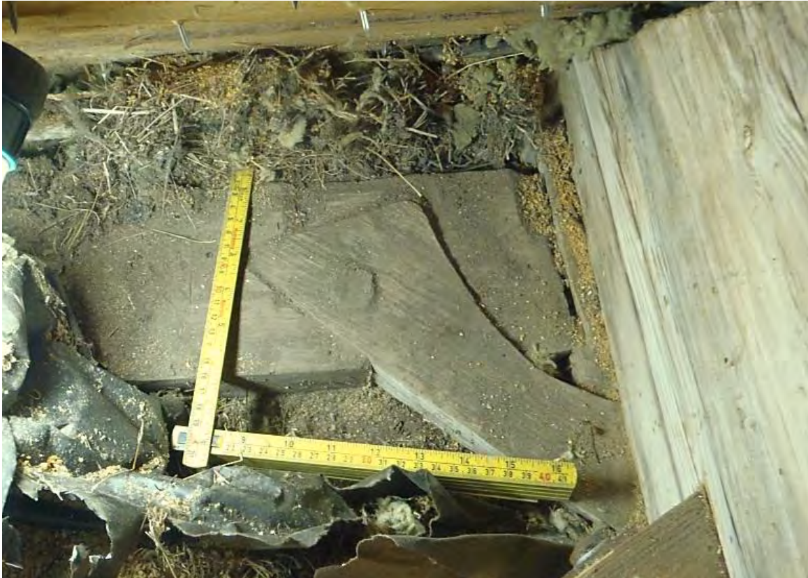
Här en bild från Jällby medeltida timmerkyrka. Bilden är tagen uppe på vinden och visar ett innerhörn med en liten diagonalsträva.
