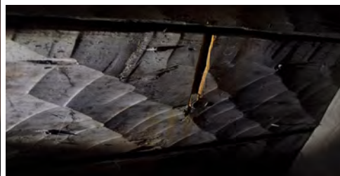
Diagonalt huggen taktro med spår efter dendropron.
