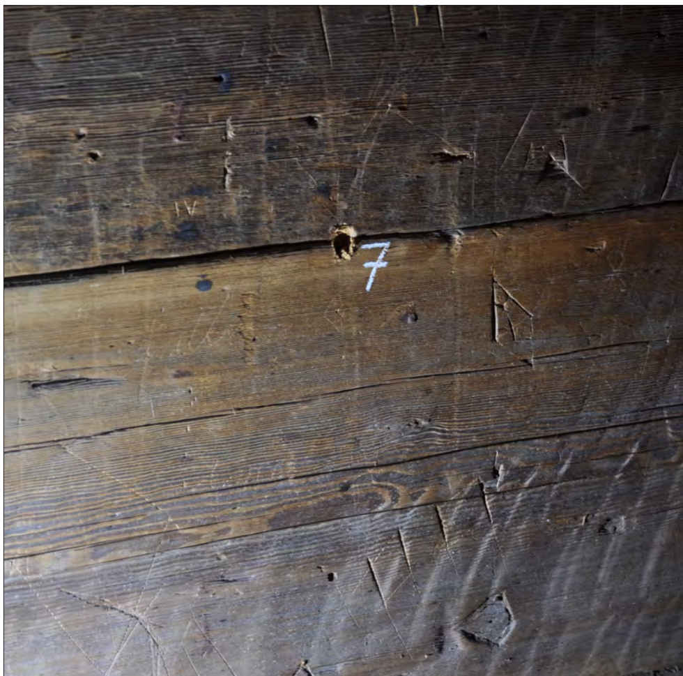
Figur 12. Väggtimmer i entrédelens insida. Det finns många olika små spår i virket, bland annat är stockarna uppmärkta med raka hugg och eventuellt är ett bomärke inristat strax höger om borrhålet från dendroprovtagningen. Foto Daniel Eriksson.
