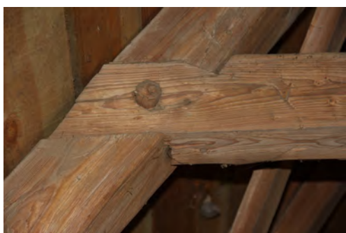
Knut med nacke i sakristian. Hanbjälke och högben är märkta.
