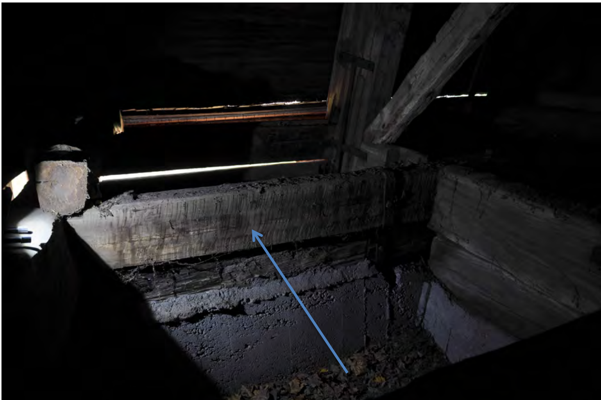
Bilden visar en av två medeltida bjälkar i klockstapelns syllkonstruktion. Dessa två bjälkar är i en betydligt kraftigare dimension än övrigt virke. De har troligen utgjort sylltimmer i en medeltida timmerkyrka. De har också en fasad kant, likt syllarna i Södra Råda gamla kyrka. (syns ej i bild) Dess placering bör göra att de ej är i riskzonen vid de reparationer som skall utföras.
