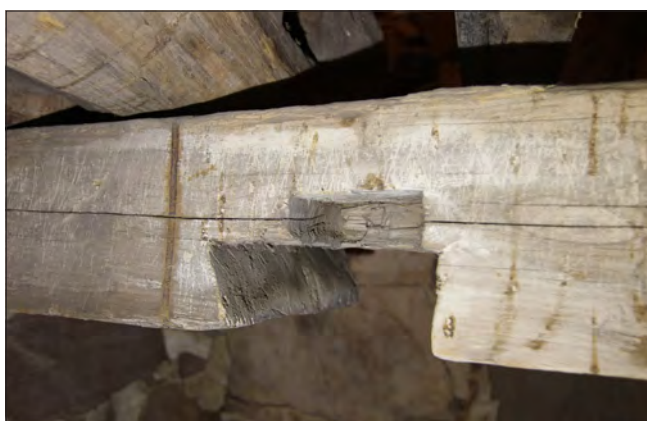
Figur 11. Väggtimmer med laxade urtag och dymlings-/tapphål med spår av navare och stämjärn.
