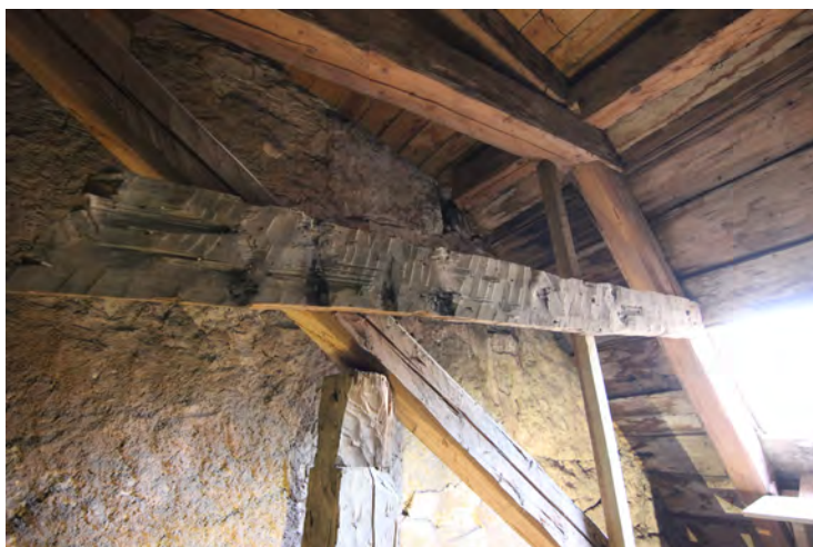
Sprättäljd och brandpärkad f.d. taktrobräda, påspikad på en takstol nära takluckan.
