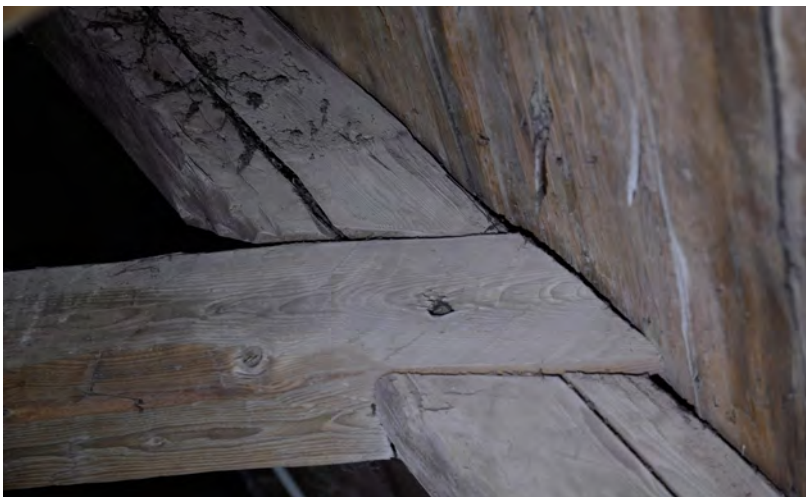
Rak bladning med spik respektive bladning halvt i halvt med spik. Foto: Daniel Eriksson.
