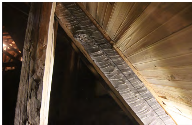
Figur 9. Sprätthuggen högben och stödben i långhusets södra takfall.
