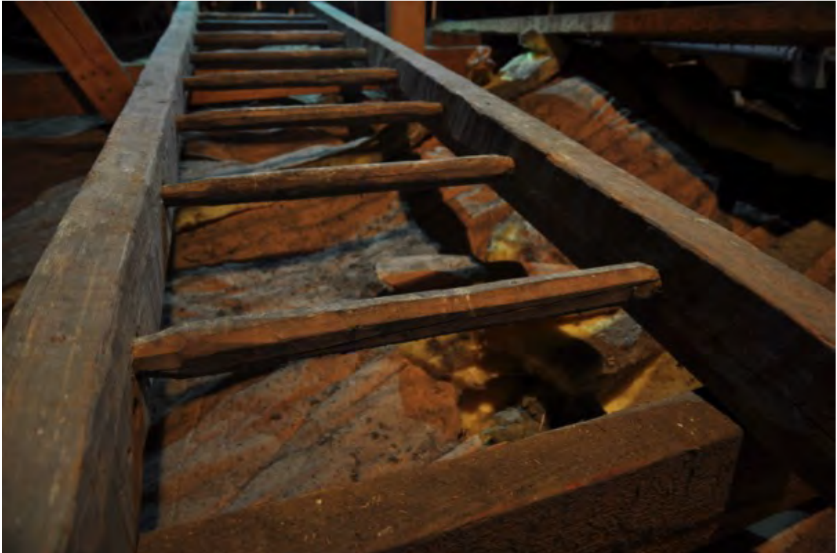
Vissa av stegpinnarna har ansetts för grova och huggits ned i dimension.
