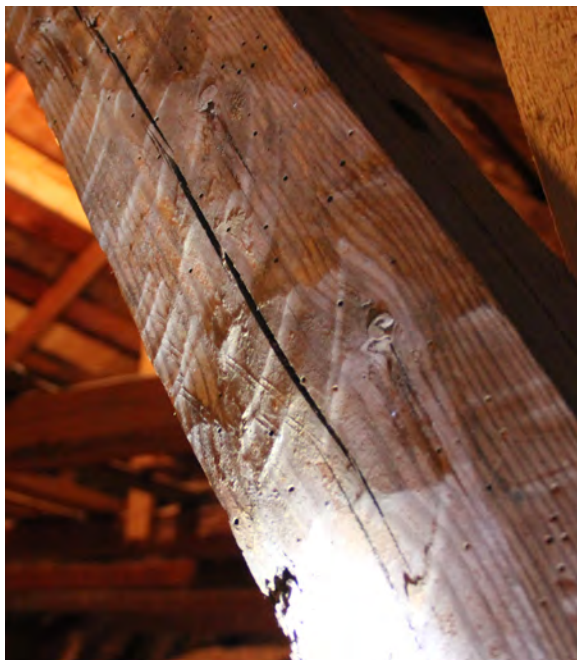
Sprättjäält högben med dylingshål, återanvänt som sträva.
