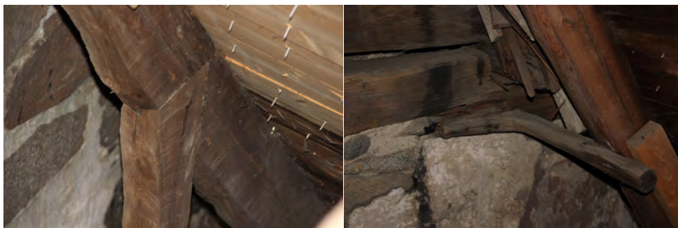
Förbindning stödben och högben i vapenbuset till vänster och högben förankrad i remstycke med rotben. Foto: Daniel Eriksson.
