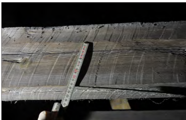
Figur 17. Behuggning i raka band som visar på yxeggens bredd. Foto Daniel Eriksson.
