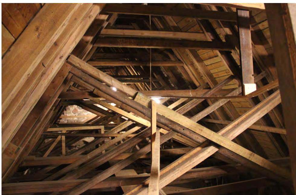
Ett virrvarr av virkesdelar, sekundära försärkningar, landgångsvirke och kabelbrädor över långhusvinden.
