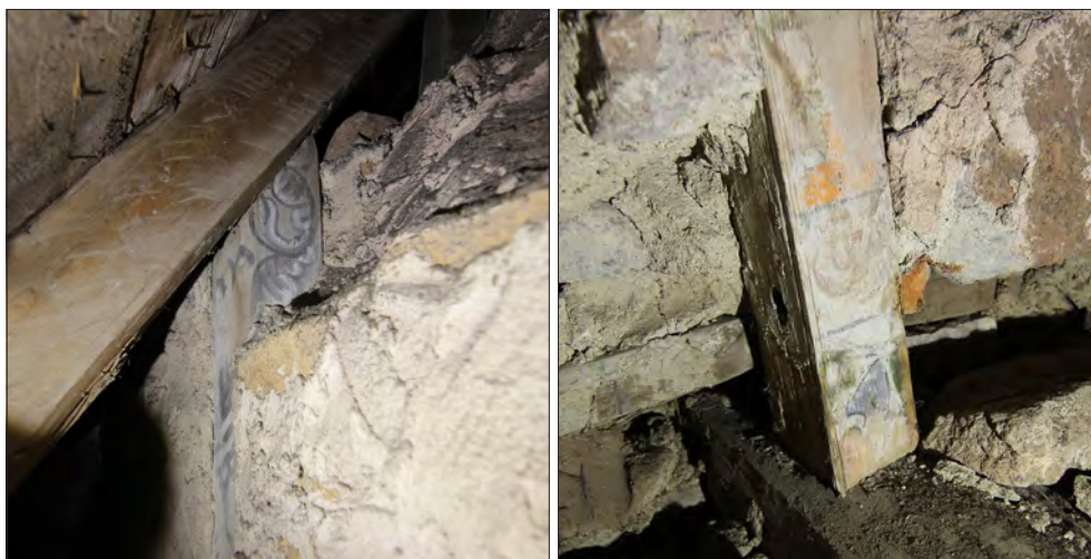
Figur 17. Bemålade bjälkar återanvända som stödben.
