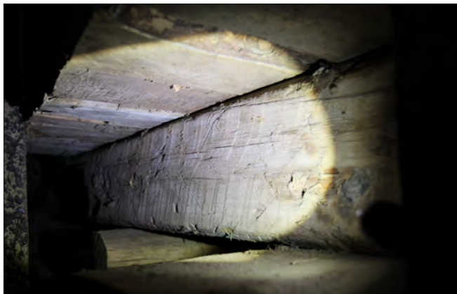
Figur 7. Medeltida timmer återanvänt i bjälklaget en halv trappa upp i klockstapeln.
