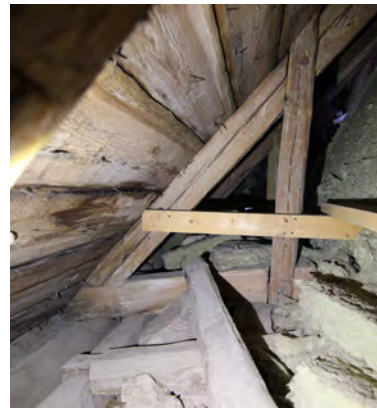
Davidskyrkan, knäbock i norra takfallet. Knut med nacke i förbindningar.
