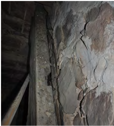
En av de återanvända timmerstockarna i Malung kyrkas torn. Timret har sprätthuggna och skavda ytor.
