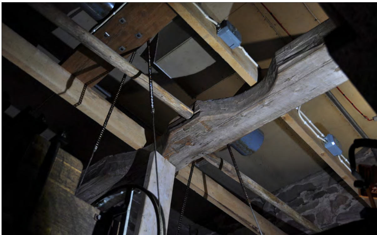
Figur 12. På en centralt monterad bjälke över klockorna finns två kraftiga urbuggningar. Dessa tolkas vara gjorda sekundärt och kanske för att bereda plats att stå vid bjälken för någon tidigare generations fotringning. Urgröpta spår, som tolkas som grepphandtag, finns också på denna stock. Timrets ena bredsida är sprättbuggen och motsatt bredsida bearbetad med skave tvärs över fibrerna. Det finns laxknutar på samma sida som den buggna sidan. Foto Daniel Eriksson.
