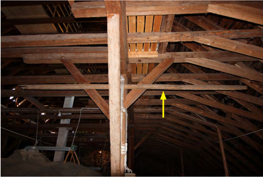
Köpings kyrka, sannolikt medeltida bjälke uppspikad på en av långbusets takstolar.
