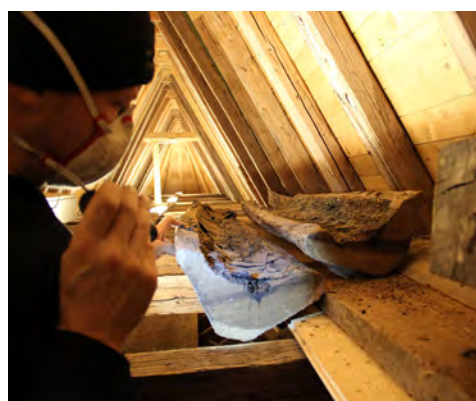
Daniel Eriksson tittar närmre på det urholkade och plätskodda ekämnet, ev. rännadal, som ligger upplagd över några hanbjälkar.
