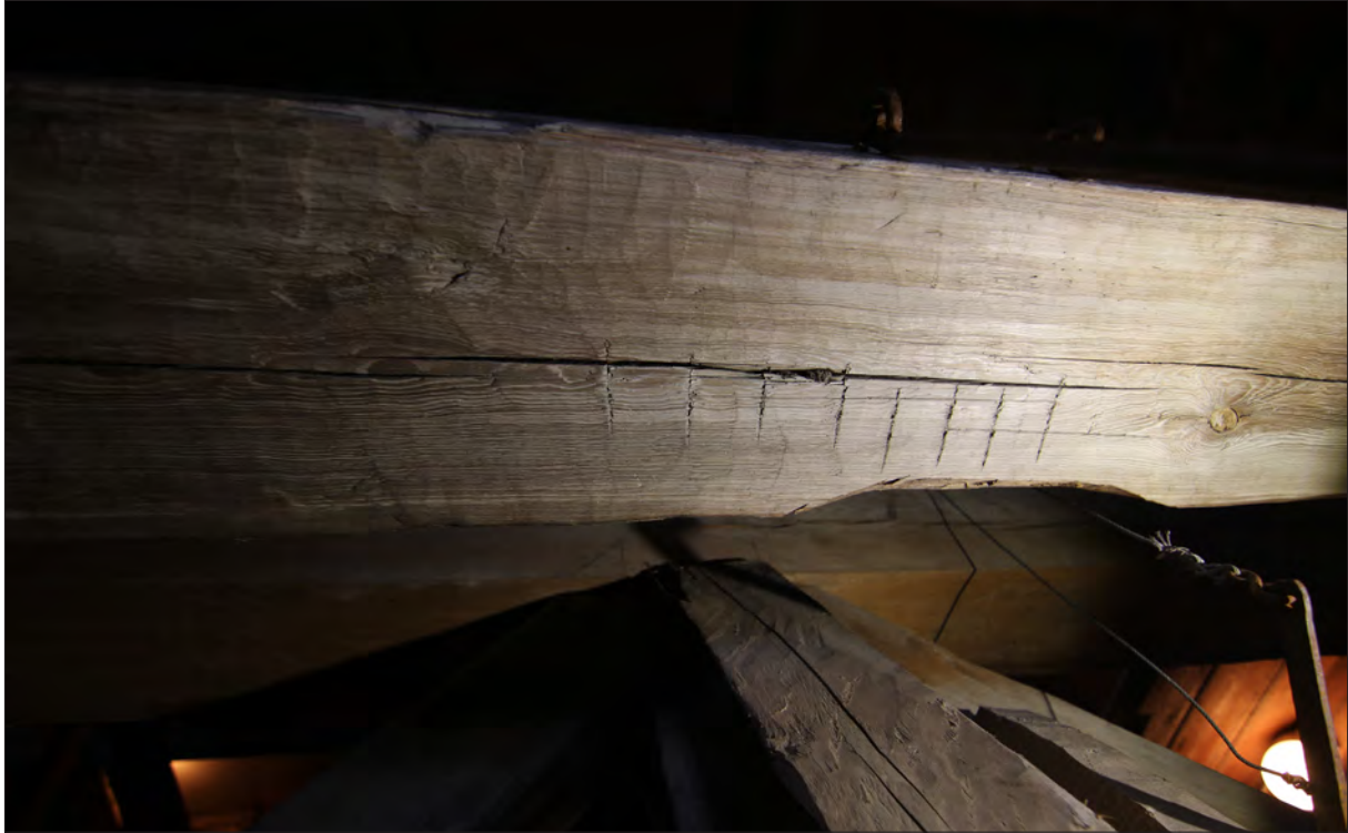
Figur 14. Flera av timren är märkta och det är gjort med yxa, som raka inbygg efter varandra. Kanske gjordes de i samband med att den tidigare byggnaden plockades ner. En kartläggning av dessa skulle kunna tydliggöra ordningen på en del av väggtimret i den tidigare konstruktionen.
