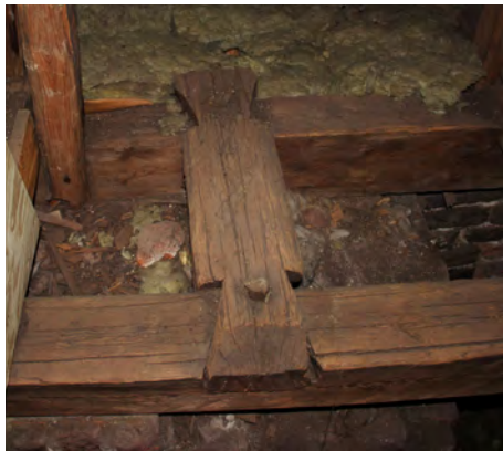
Munktorp långhus. Laxad kortling mellan yttre och inre remstycke.
