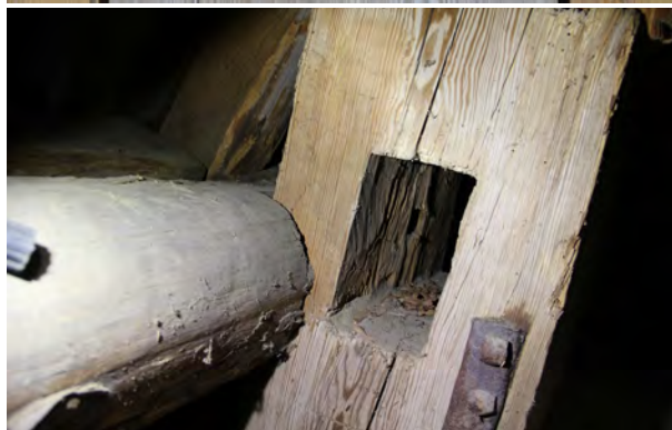
Sydöstra hörnstolpen, nedtill, urtag för tvärplank nära befintlig golvnivå. Markering med ritsar och ett genomgående dymningshål.
