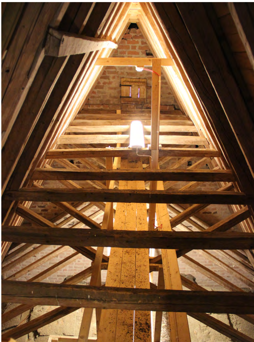
Fotot visar takkonstruktionen över södra korsarmen.
