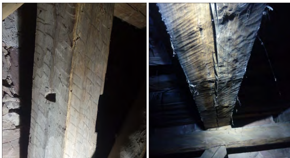
Figur 16. Till vänster syns sprätthugget timmer under klockväningens bjälklag. Behugningen är utförd i flera jämna band utmed stockarnas sidor och någorlunda vinkelrätt. Till höger syns en timmerstock monterad i klockväningens bjälklag som liksom flera andra har sin ena bredsida bearbetad med skave. Foto Bengt Bygdén.
