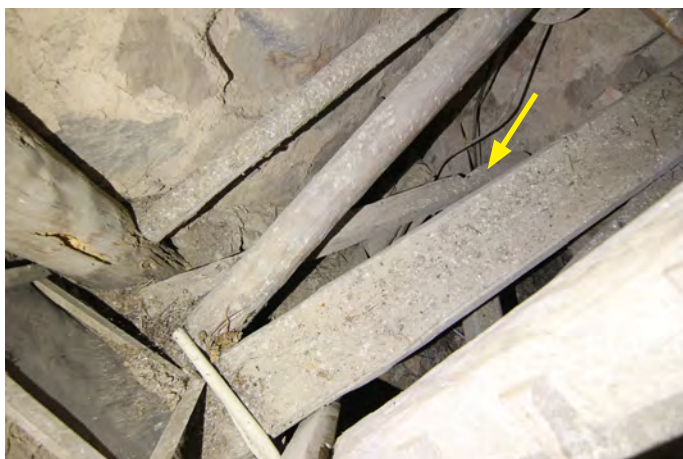
Bjälke med snett urtag markerad med gul pil. Kan vara f.d. högben. Den ligger nedanför trappen i tornet.
