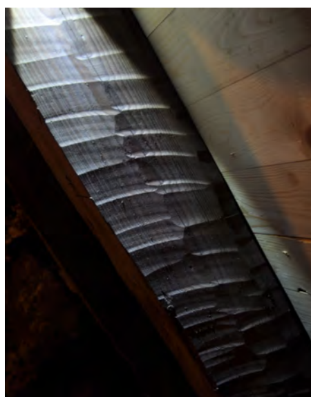
Till vänster, en bit av en sågad bräda med året 1468 inskuret. Skall enligt uppgift ha varit en del av en taktrobräda och förvaras i sakristian. Till höger, sprättäljt högben. Foto: Daniel Eriksson.
