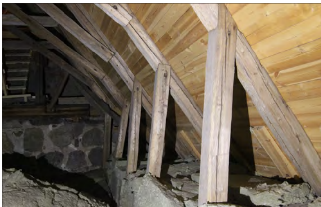
Figur 18. Västra takfallets knäbockar i sakristian, sedda från norr.
