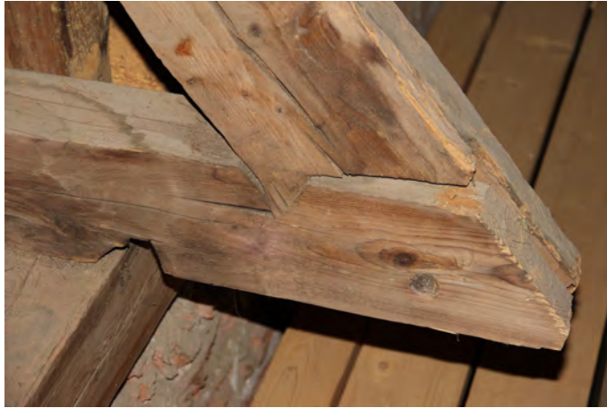
Munktorp långhus. Knut med nacke i förbindningen böggen och stickbjälke.
