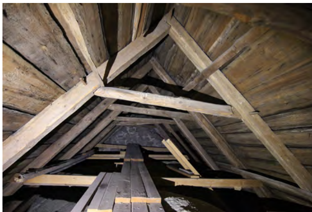
Munktorp långhus. Laxad kortling mellan yttre och inre remstycke.
