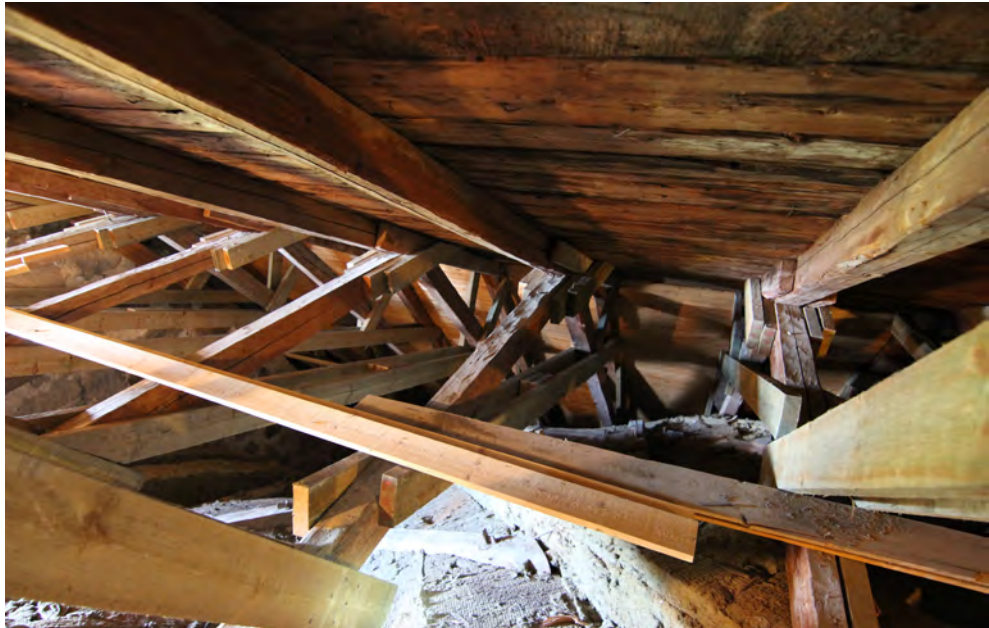
I sydöstra takfallet finns minst tre generationer takträbrädor; bilade, ramsågade och modern råspont.
