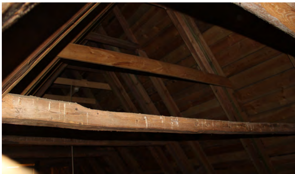
Före detta avsmalnat högben återanvänt som hanbjälke över långhusvinden.
