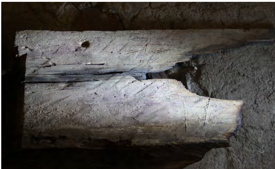
Västerås domkyrka. Avbränd del av remstykke från norra korsarmen. Huggspår är synliga. I bjälkens "ovansida" finns en rund skålformad fördjupning. Kanske har ämnet tjänat som underlag för ett annat trä ämne som man borrar hål igenom.
