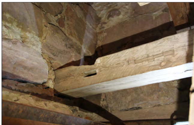
Figur 9. Väggtimmer med slackt långdrag och rektangulärt tapphål.
