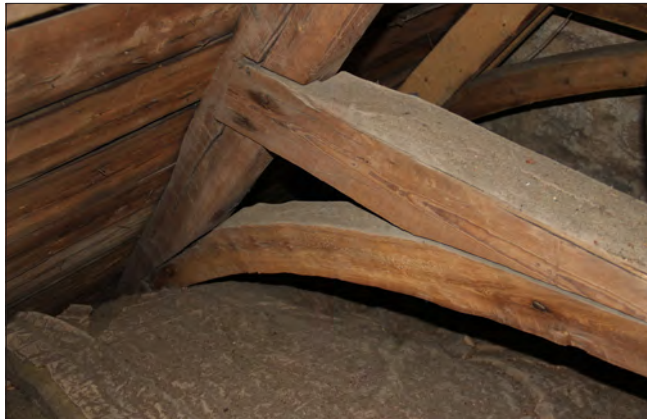
Figur 32. Förbindningar mellan hanbjälke-högben och hanbjälke-valvbåge i vapenhuset.
