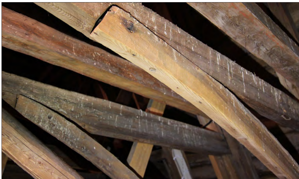
Figur 20. Valvbåge i takstol nr 9 infäst med spik och tränagel av ek.
