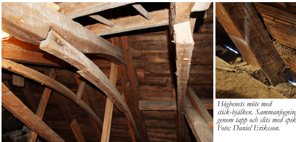
Hanbjälken har en extra bågform på vardera sidan om valvhjässan.
