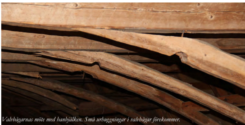
Takstolskonstruktion i Kila långhus.
