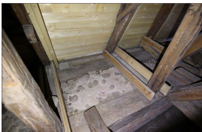
Figur 2. Remstycken i tornet, sannolikt från uppförandetiden.
