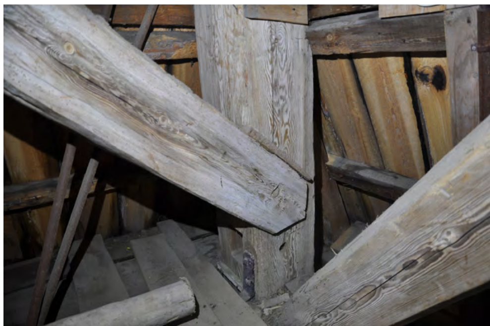
Hörnben och krysssträvor nedtill i konstruktionen. Foto: Daniel Eriksson.
