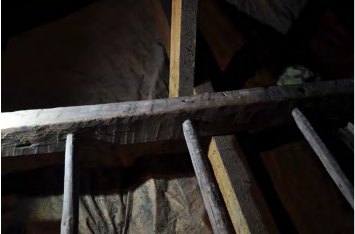
Sprätthuggning. Till höger syns ett spikhål.
