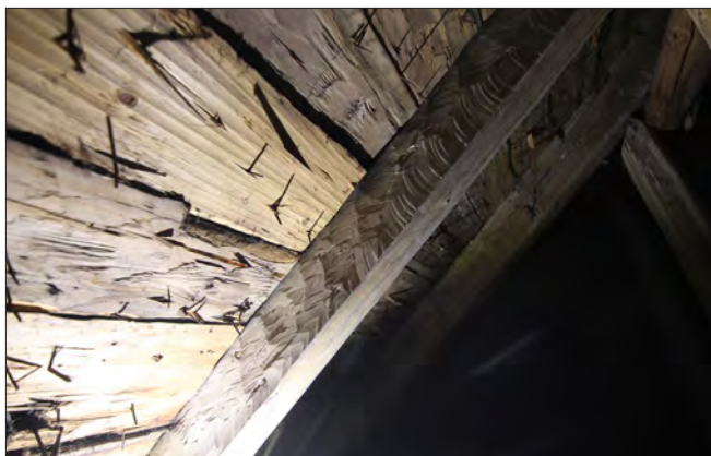
Figur 14. Högben med bebuggning i olika riktningar och taktrobräda bearbetad med skave.
