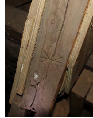
Munktorp långhus. Bomärke eller timmermansmärkning på böggen. Notera att träskivor skruvats i dess sidor.
