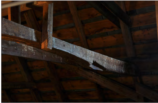
Figur 11. Hanbjälken på takstol nr 14 har huggits ur för valvhjässan och det finns även en rits. Foto Daniel Eriksson.
