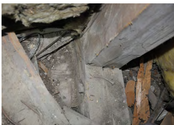
Till vänster, knäbocken med urhuggning för valv i stödbenet. Övan en närbild från knäbocken. Stickbjälken är skråspikad i remstycket. Foton: Daniel Eriksson.
