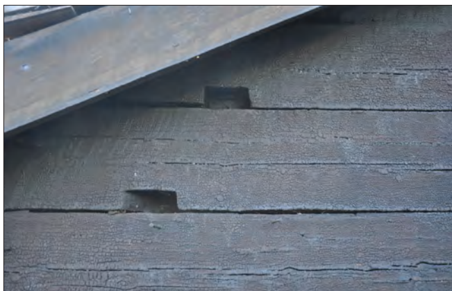
Figur 4. Sprättbuggningen syns genom tjäran och urtag i form av snedställda laxstjärter. Foto Daniel Eriksson.
