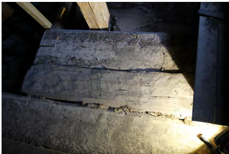
Orsa kyrka, vind över sakerstia. Sprättäljd trobräda återanvänd i landgången.
