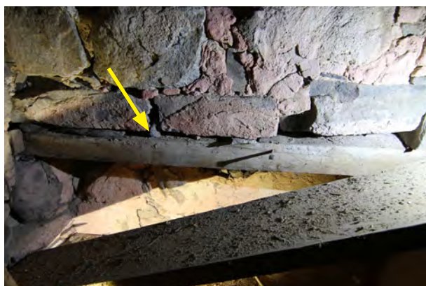
Bjälken i västra väggen markerad med gul pil.
