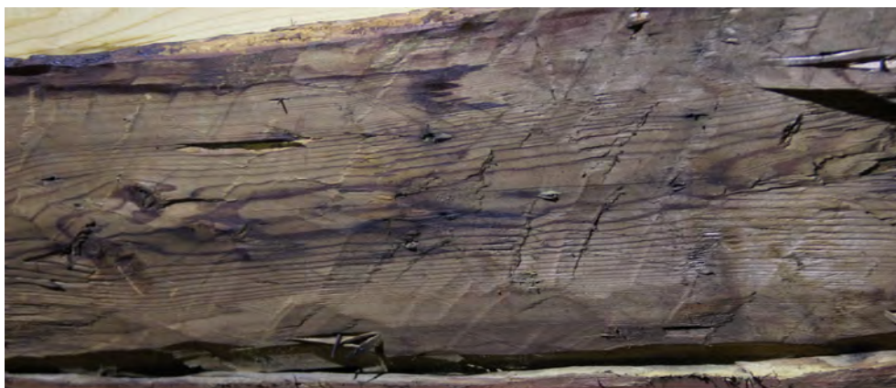
Återanvänd, huggen trobräda i södra takfallet.
