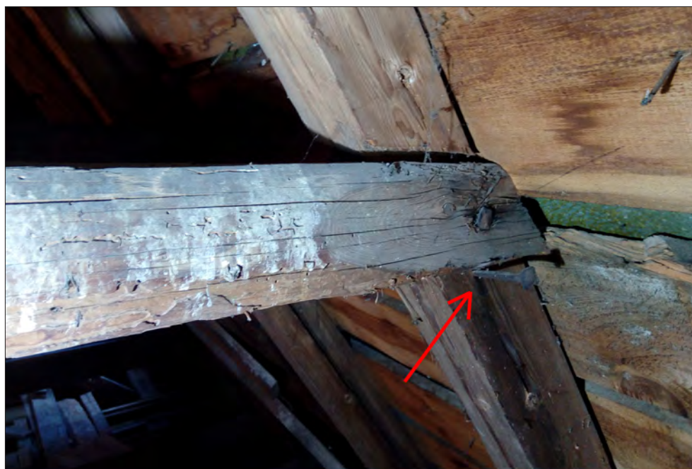
Figur 10. Uppslagsspik berättar att hantverkaren troligen jobbade ensam vid infästningen av hanbjälken i högbenet. Foto Bengt Bygdén.
