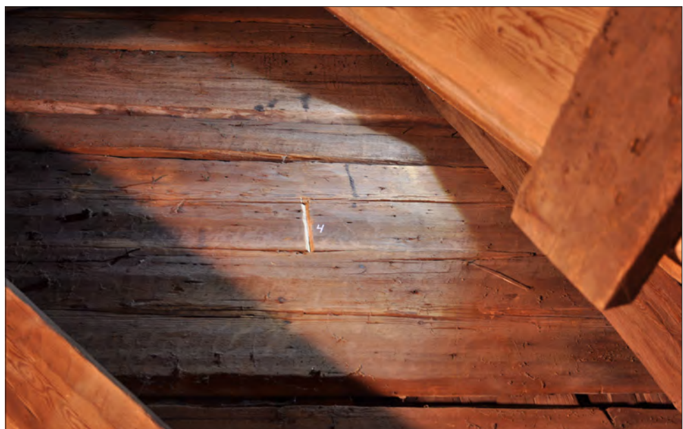
Figur 11. Medeltida panel med V-format sågspår från dendroprovtagning. Foto Daniel Eriksson.
