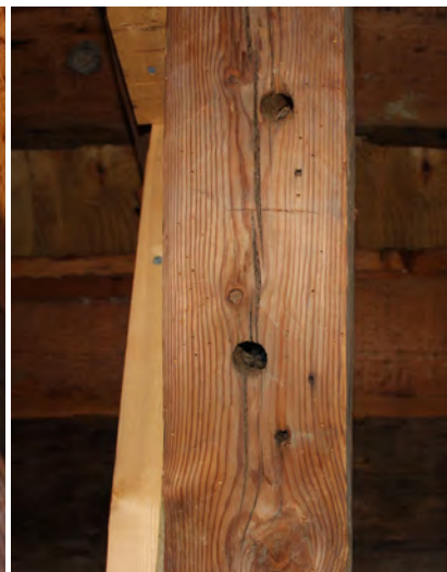
Sprättjäält högben med dylingshål, återanvänt som sträva.
