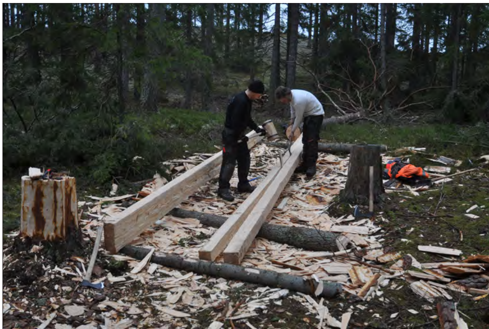
Figur 12. Rekonstruktionen av Södra Råda gamla kyrka. Daniel Eriksson och Karl-Magnus Melin tillverkar sparrar/bögben genom att klyva fram fyra ämnen ur en grövre stock. Foto Daniel Eriksson.
