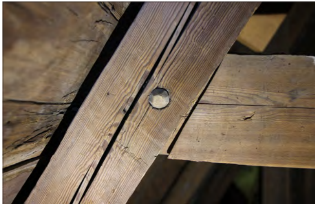
Figur 24. Dymling med täljd skalle i takstol nr 14, norra takfallet.
