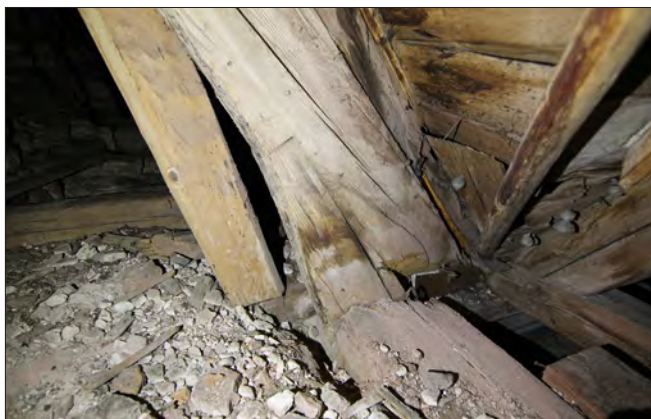
Figur 7. Del av gaveltakstolen i 1300-talskyrkan med en påspikad förstärkning av kraftigare virke på bögbenets insida.
