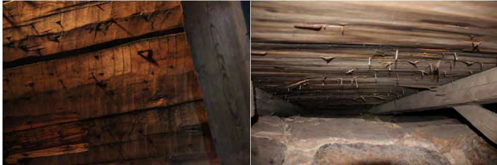
Taktro som är sprättäljd respektive bearbetad med skave i Malung.
