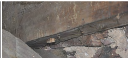
Fotot till vänster visar ett långsgående spår i timret. Man har först borrar sedan huggt rent. Det som troligen varit undersida har en konkav yta. Bilden ovan visar ett rektangulärt hål med dymlingen kvar. Foton: Daniel Eriksson.
