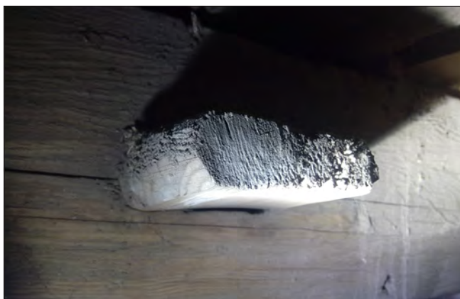
Figur 10. Kvarsittande dymling/tapp. Foto Bengt Bygdén.
