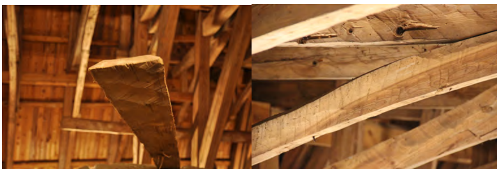
Bilden till vänster visar lösfynd av bräda som kan komma från tunnvalvet. Ena sidan huggen, andra sidan skavd. Foto: Daniel Eriksson. Till höger en närbild på behuggningen.
