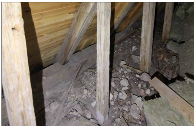
Figur 5. Störbjälke utmed norra murkrönet. De ligger närmast högbenen och har urtag för inpassningen mot högbenen och griper över stickbjälkarna (före detta bindbjälkar) med ett hak. Mot remstycket har en av bjälkarna passats in genom en urbuggen fals.
