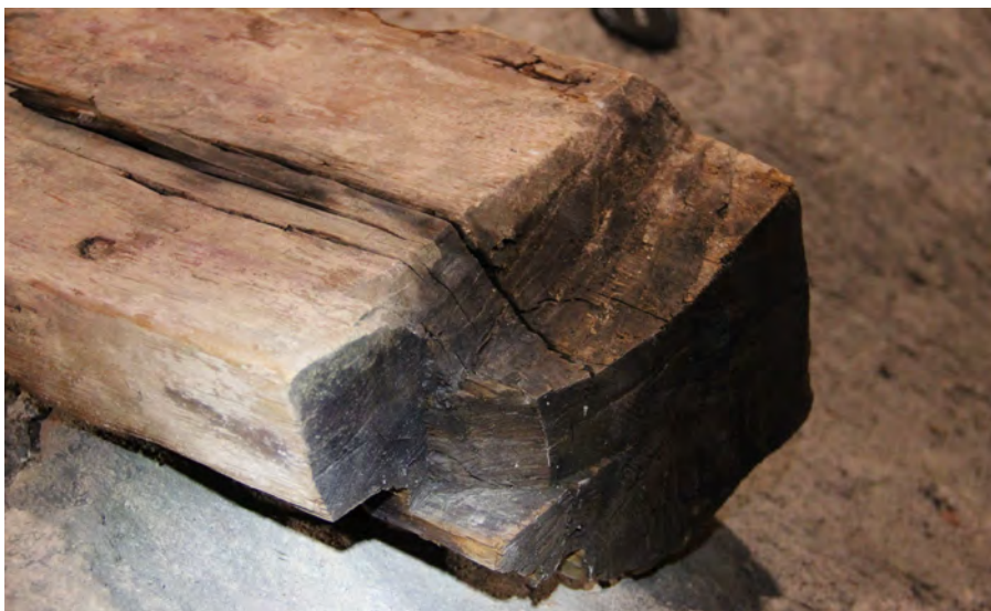
Samma del som ovan. I ändrät finns spåren efter ett hak med en sned och en rak sida samt en huggen avfasning i det som utgjort bjälkens ovankant.
