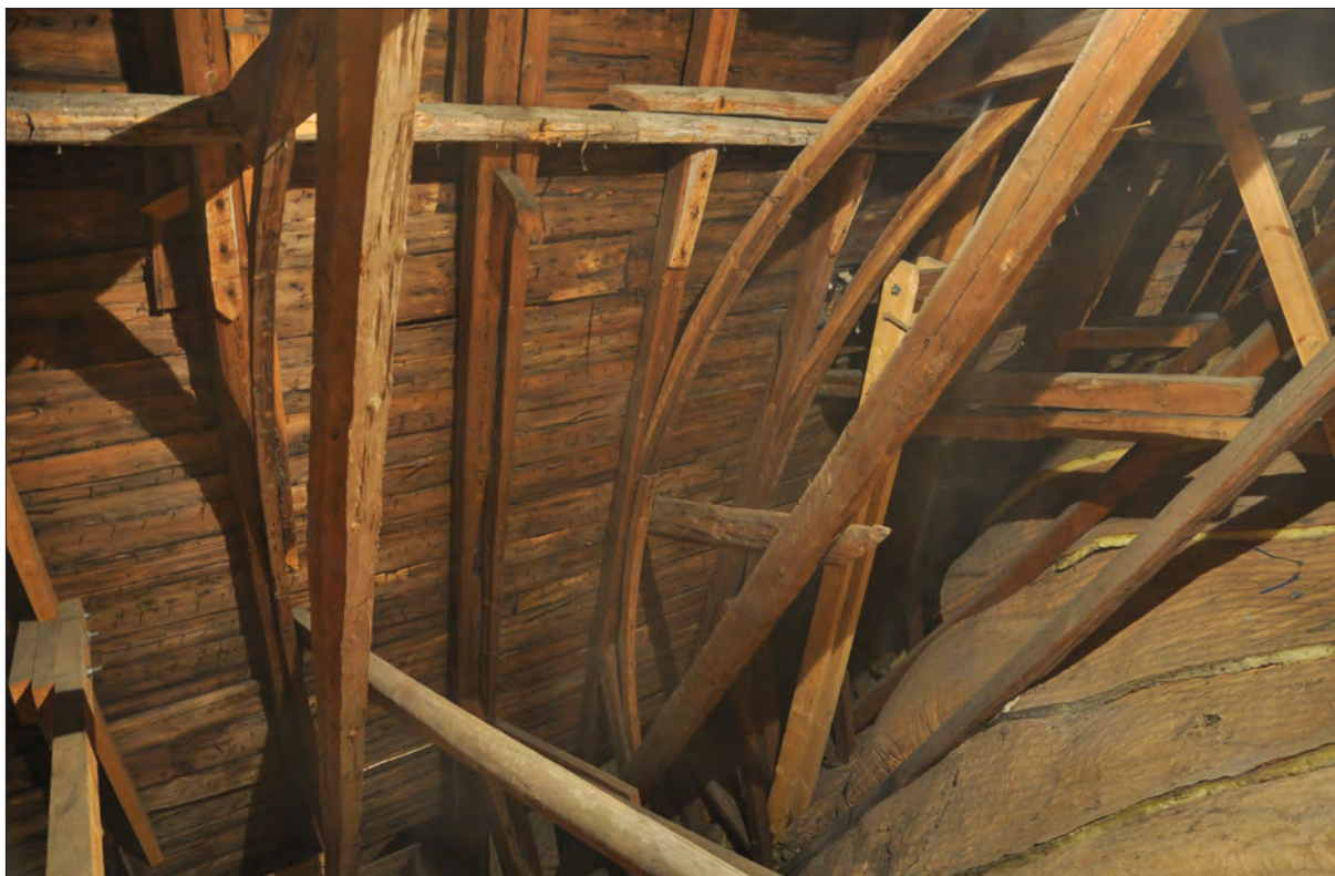
Figur 6. Del av takkonstruktionen över västra delen av långhuset, norra takfallet. Trävalvets form kan anas. Olika generationers förstärkningar syns också. Foto Daniel Eriksson.
