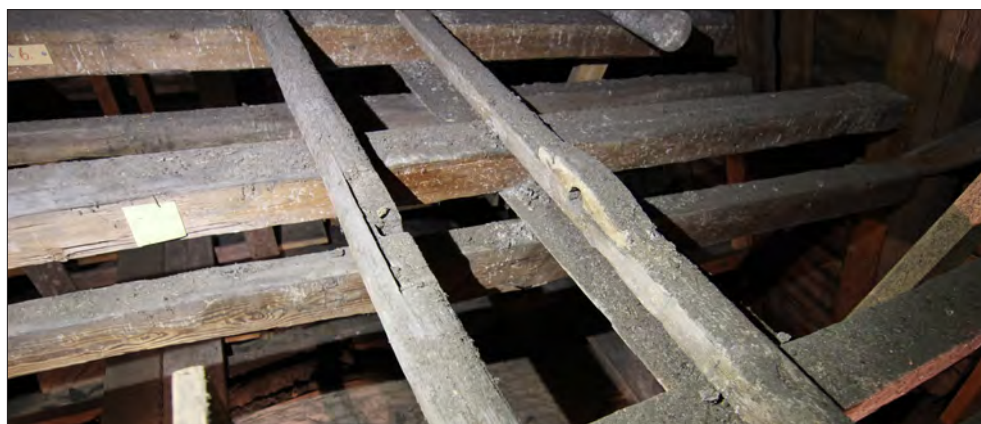
Figur 26. Klockupphängning över koret.
