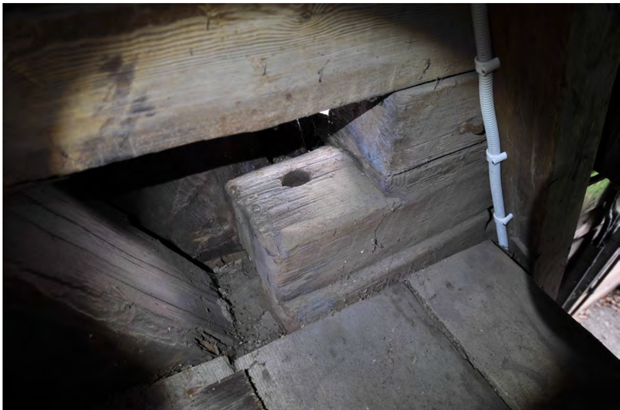
Flera knutar finns bevarade. De är utförda på samma vis som Södra Råda gamla kyrka, det vill säga raka bladningar med en liten dympling som låsning.
