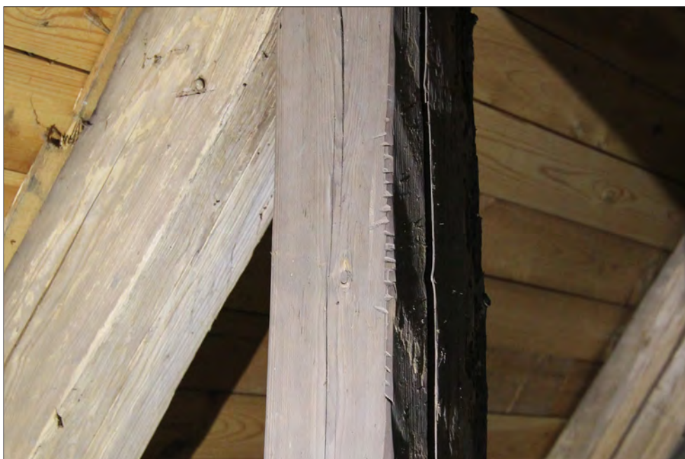
Figur 19. Märkning i form av små hack finns i stödbenet i tredje takstolen från norr, västra takfallet.
