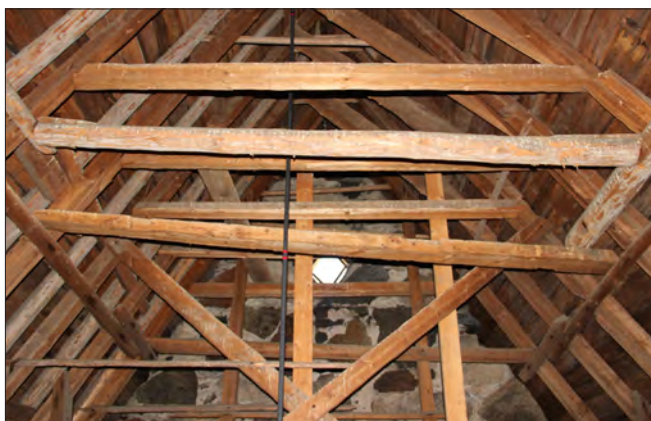
Figur 7. Övre delen av taklaget i västra delen av långhuset.
