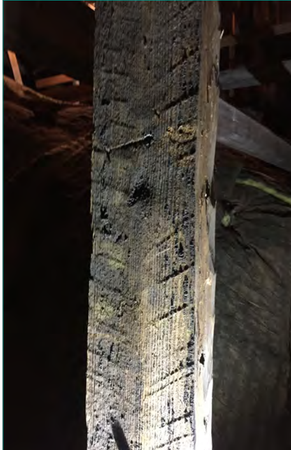
Figur 14. Sprättbuggen bjälke med tjärrester som berättar om att delen ingått i en gaveltakstol och varit exponerad utvändigt. Foto Daniel Eriksson.
