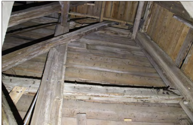
Figur 24. Delar av konstruktionen fotograferad från botten våningen och uppåt.
