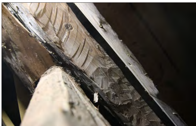
Figur 12. Högben med olika behuggning som möts.
