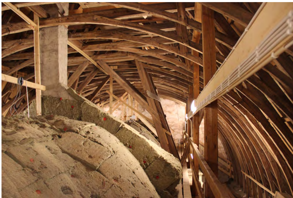
Taklagets södra sida mot öster. I bild syns nedre delen av bockkonstruktionen.
