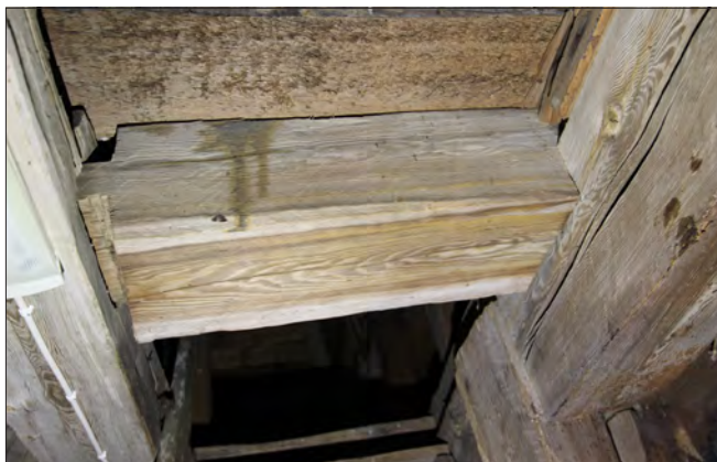
Figur 21. Kortling mellan hammarband och bindbjälke i övre ramen.
