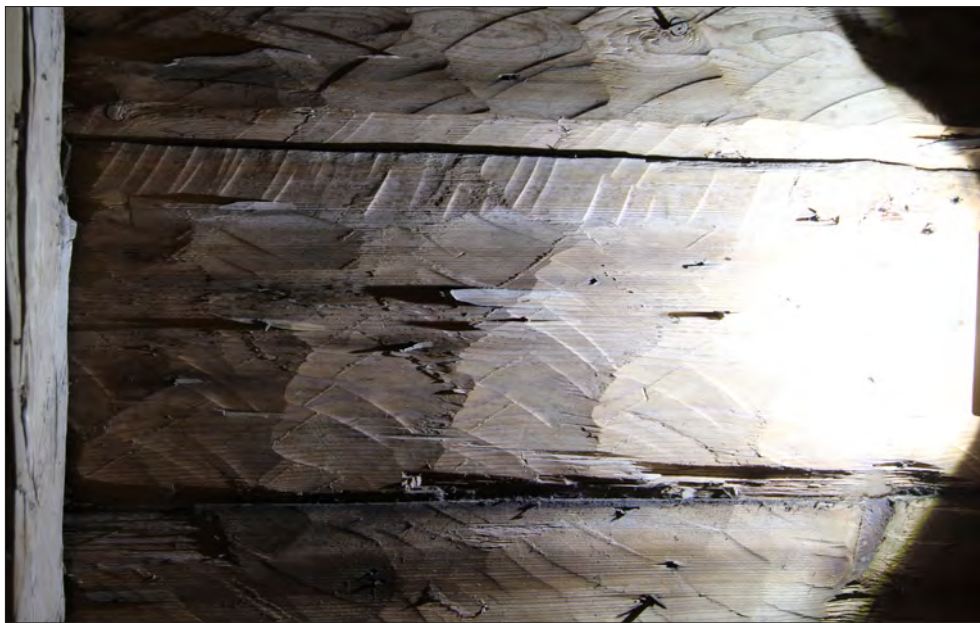
Figur 18. Taktrobrädor uppvisar sparsamt med spikhål.
