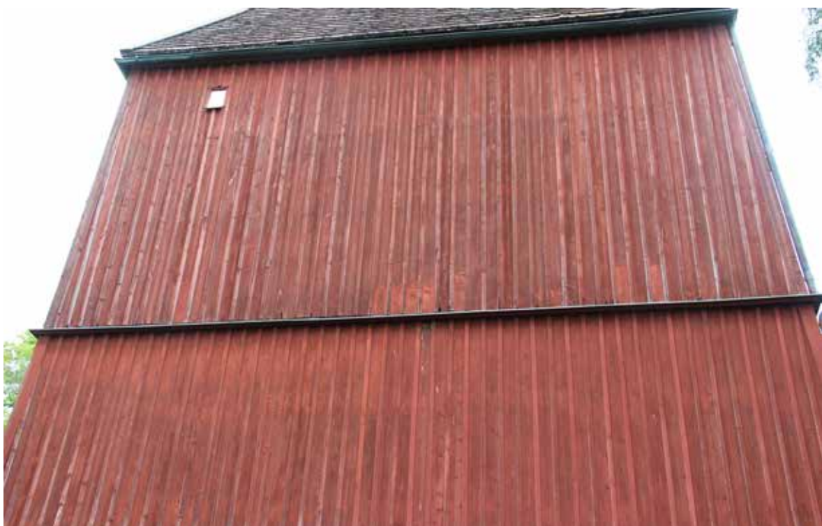
Figur 7 nedan. KM15093_006. Del av norra fasaden innan åtgärder. Foton: Lisa Skanser.
