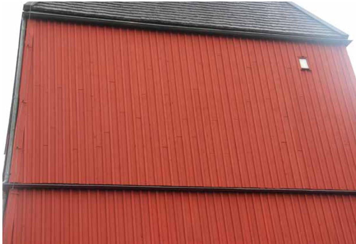
Figur 11. KM15093_032. Del av norra fasaden efter reparation av panel och slutstrykning med slamfärg. Foto: Lisa Skanser.
