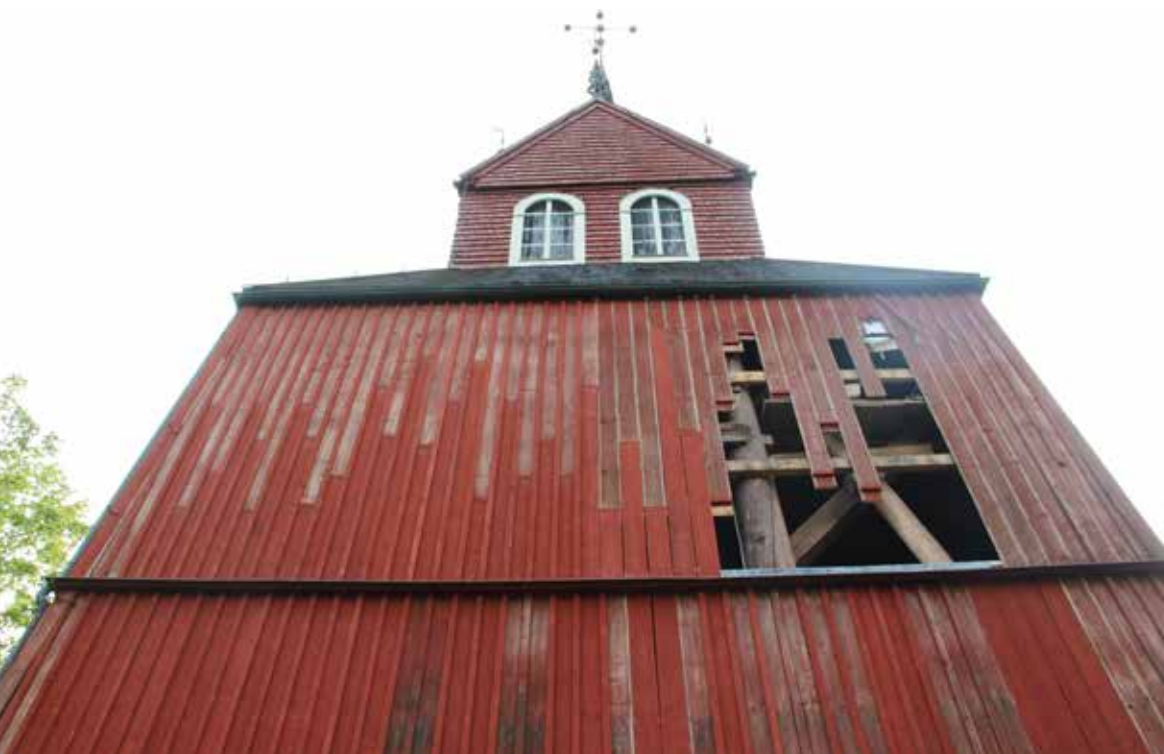
Figur 10. KM15093_022. Del av norra fasaden under arbetet med utbyten och skarvning av panelbrädor. Utbytta delar är grundstrukena med slamfärg. Foto: Lisa Skanser.
