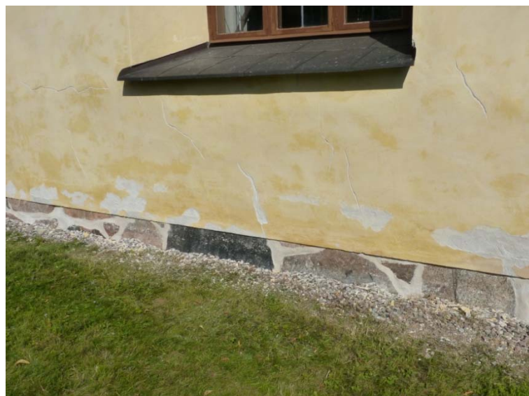
Figur 24. Ytterligare exempel på restaureringen av fasadputs. Här södra fasaden. Foto: Tobias Mårud.
