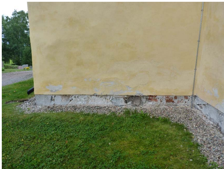
Figur 9. Här har arbetet med friläggningen av sockeln inletts. Observera den med tegel igenmurade dörröppningen i högra delen av sockeln. (Visar Mariakapellets västra fasad.) Foto: Tobias Mårud.
