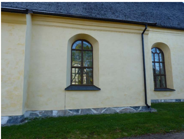
Figur 27. Mariakapellets norra fasad, samt delar av sakristians och långhusets norra fasader, efter restaurering. Foto: Tobias Mårud.
