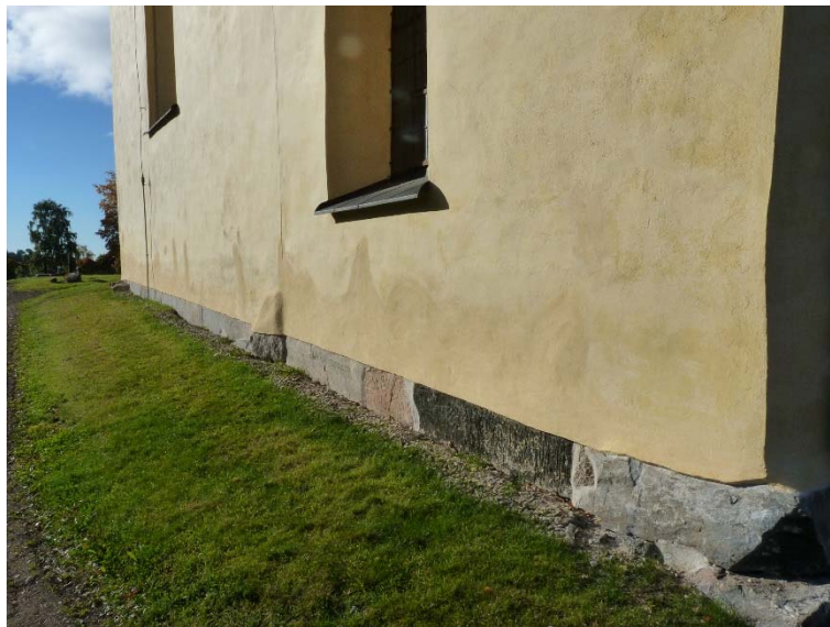
Figur 28. Östra gaveln efter restaurering. Foto: Tobias Mård.
