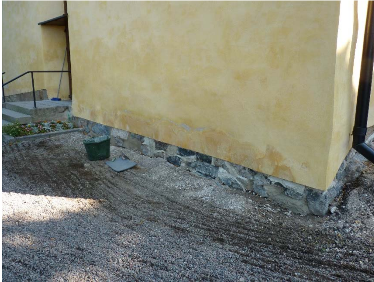
Figur 13. Västra gavelns södra fasad efter sockelns friläggning. Fogning av murverket under utförande. Foto: Tobias Mårud.
