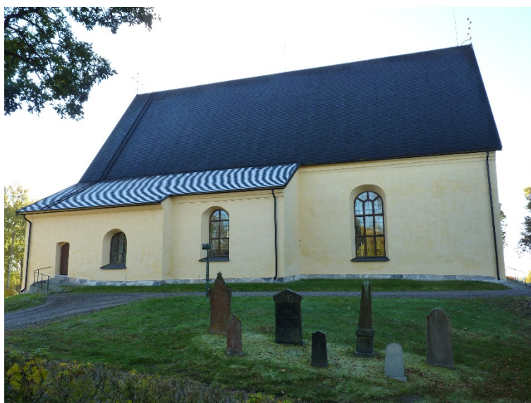
Figur 29. Kyrkan sedd från norr efter utfört arbete. Foto: Tobias Mård.
