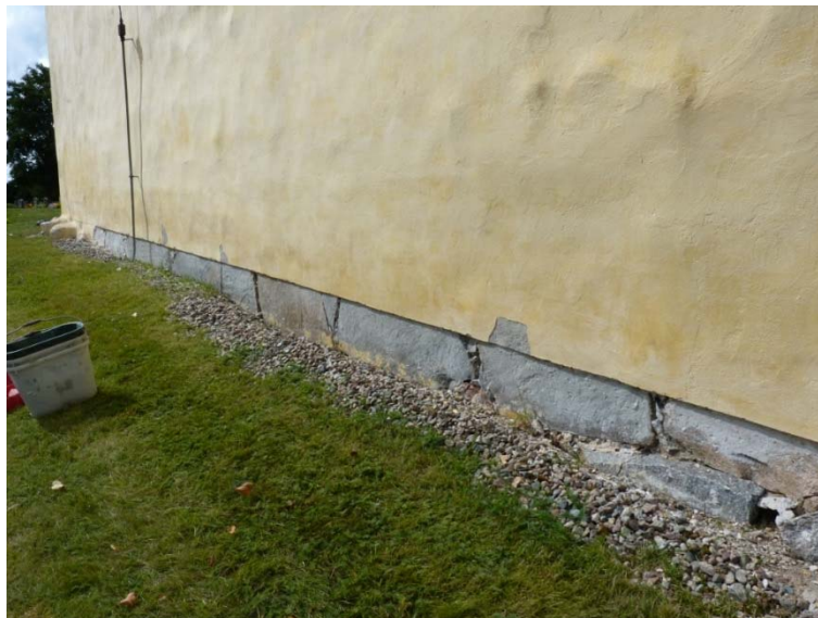
Figur 17. Östra gavelns sockel under friläggande. Foto: Tobias Mårud.
