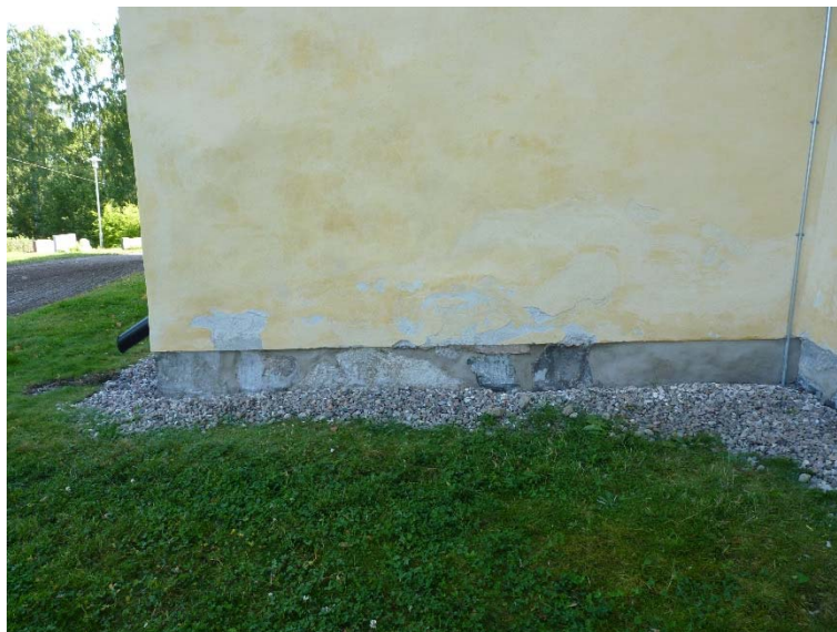
Figur 10. Sockeln under arbetet med fogning. Tegelmuren i den tidigare dörröppningen har putsats över. (Visar Mariakapellets västra fasad.) Foto: Tobias Mårud.
