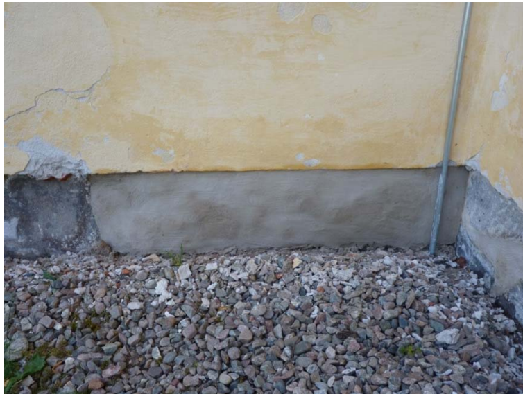
Figur 20. Samma parti direkt efter putsning. Foto: Tobias Mårud.
