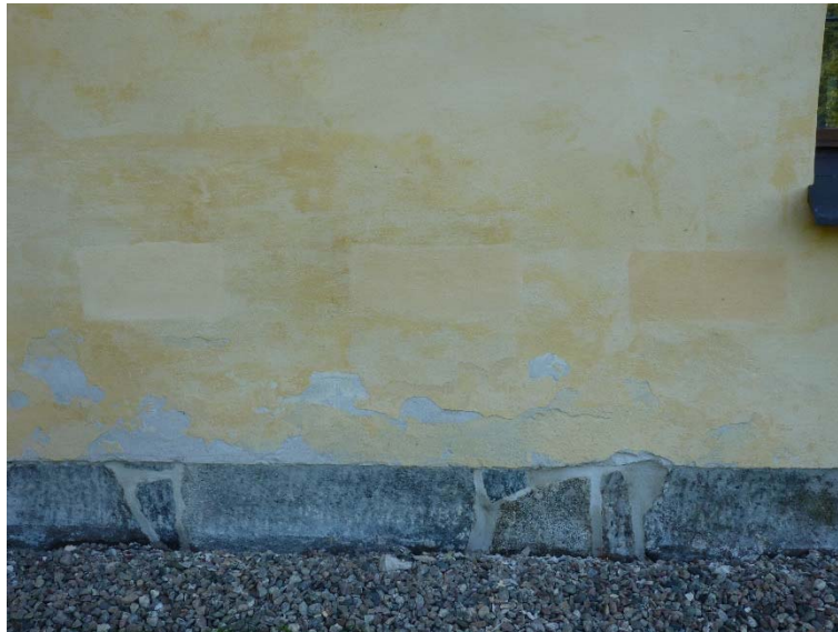
Figur 26. Tre kulörprover ströks upp på norra fasaden. Valet föll på den mellersta. Foto: Tobias Mårud.
