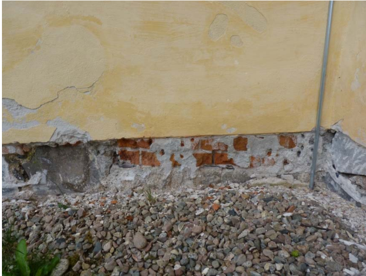
Figur 19. Detalj av den tidigare nämnda igenmurade dörröppningen i Mariakapellets västra fasad. Foto: Tobias Mårud.
