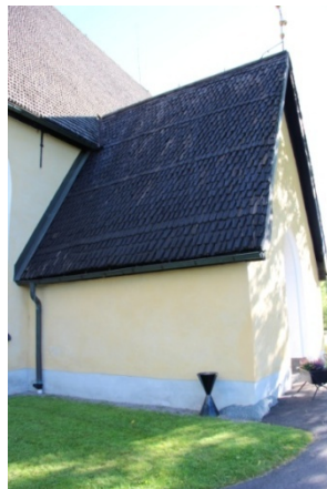
Figur 22. Vapenhusets västra takfall med äldre näbbspån, efter tjärning. Foto: Helén Sjökvist. Figur 23. Vapenhusets östra takfall efter tjärning. Foto: Helén Sjökvist.
