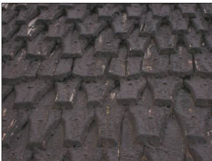
Figur 3. Näbbspån på Sala sockenkyrkas vapenhus västra takfall med spår av tidigare använd stenkoltjära. Foto: Helén Sjökvist.
