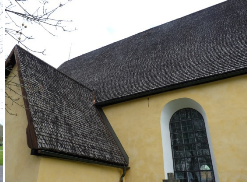
Figur 7. Vapenhusets västra takfall före tjärning. Foto: Helén Sjökvist.
