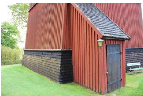
Figur 38. Den tjärade "kjolen" på klockstapelns har inte omfattats av årets arbeten utan kvarstår till en rödfärgning av fasaden inom några år. Foto: Helén Sjökvist.
