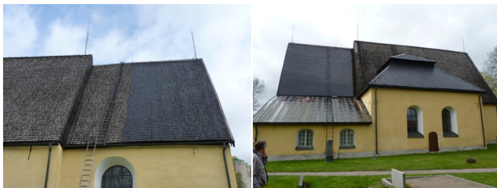
Figur 5. Pågående tjärstrykning på korets södra takfall. Foto: Helén Sjökvist.
