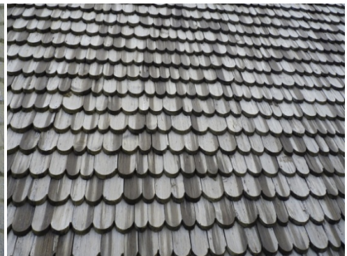
Figur 11. Klockstapelns norra sida med tjocka lager äldre tjära och omfattande algangrepp. Foto: Helén Sjökvist.
