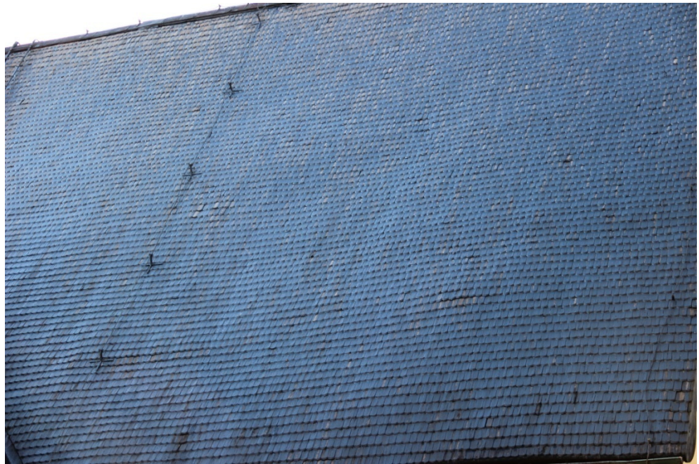
Figur 21. Långhusets norra takfall efter tjärning. Man anar att vissa spån börjar bli lite dåliga. Foto: Helén Sjökvist.
