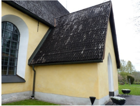
Figur 7. Vapenhusets västra takfall före tjärning. Foto: Helén Sjökvist.
