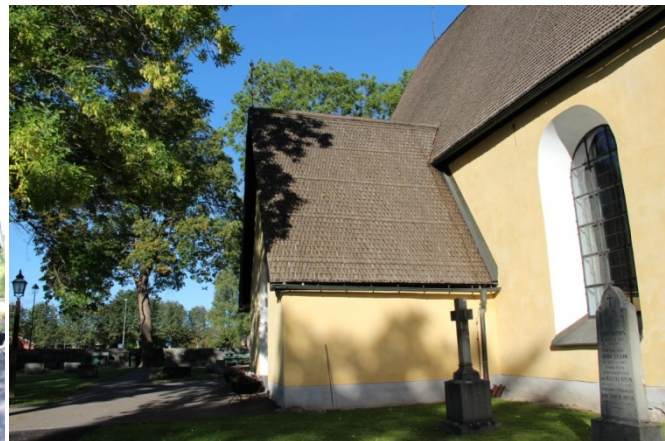
Figur 22. Vapenhusets västra takfall med äldre näbbspån, efter tjärning. Foto: Helén Sjökvist. Figur 23. Vapenhusets östra takfall efter tjärning. Foto: Helén Sjökvist.
