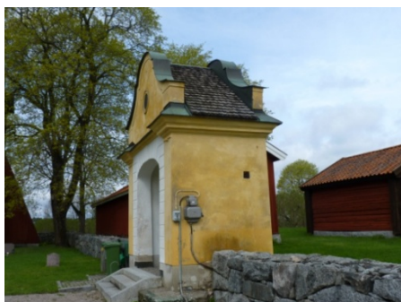
Figur 15 och 16. Också stigluckornas spån har tjärats. Foto: Helén Sjökvist.
