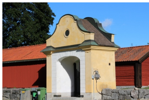
Figur 15 och 16. Också stigluckornas spån har tjärats. Foto: Helén Sjökvist.
