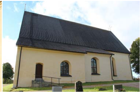
Figur 32. Vapenhusets östra sida efter tjärning. Foto: Helén Sjökvist.
