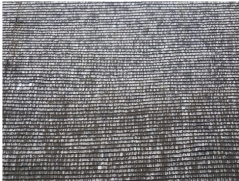
Figur 9. Långhusets norra takfall före tjärning. Foto: Helén Sjökvist.
