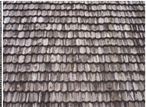
Figur 9. Långhusets norra takfall före tjärning. Foto: Helén Sjökvist.
