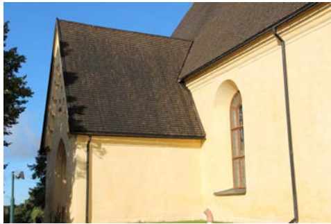
Figur 32. Vapenhusets östra sida efter tjärning. Foto: Helén Sjökvist.
