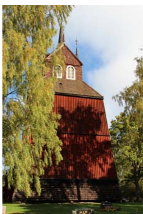
Figur 36. Klockstapelns sedd från sydväst efter tjärning av spån. Foto: Helén Sjökvist.
