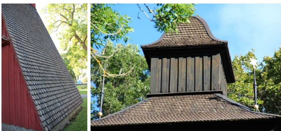
Figur 28. Klockstapelns västra sida efter åtgärder. Foto: Helén Sjökvist.
