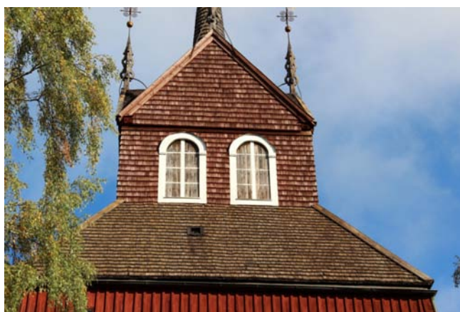
Figur 36. Klockstapelns sedd från sydväst efter tjärning av spån. Foto: Helén Sjökvist.
