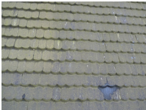
Figur 11. Klockstapelns norra sida med tjocka lager äldre tjära och omfattande algangrepp. Foto: Helén Sjökvist.
