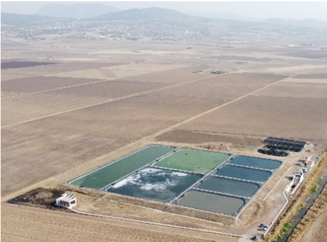
Planta de tratamiento que trata el 40% del agua de Apan
