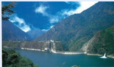
德基(達見)ダム
