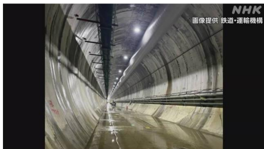
北海道新幹線のトンネル工事 熊谷組など4社がうその報告
