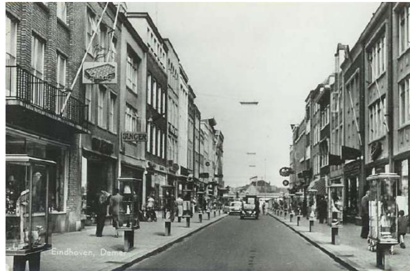
Glazen vitrines en een autoweg over de Demer 1965 Stichting Eindhoven in Beeld
