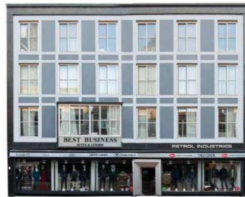
Demer 47 herstel stucwerk incl. verfraaien kleur verwijderen haakse reclame verwijderen aircos op erker
