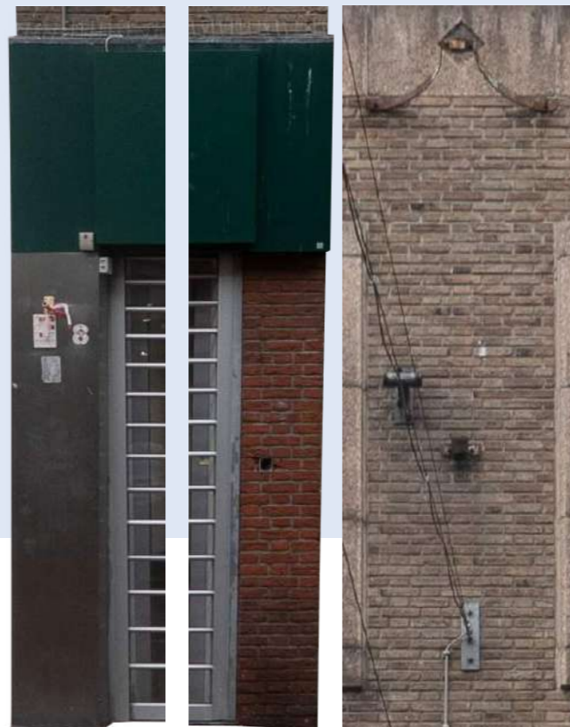
Voorbeelden huidige situatie: verschillende afwerkingen op de penanten en een scala aan ongebruikte bevestigingsmid-
