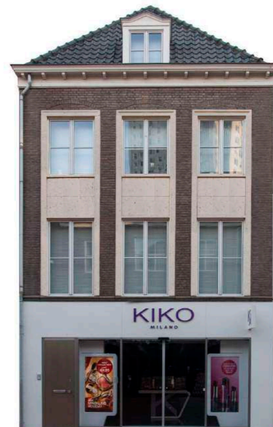
Demer 41 fatsoeneren hemelwaterafvoer en kabelgoot aanpassen kleur natuursteen kaders verdiepingen
