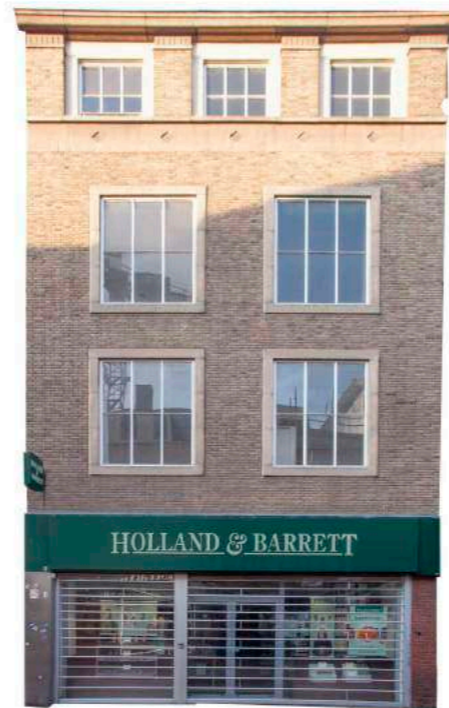
Demer 8 reinen en opschonen gevel verdiepingen
