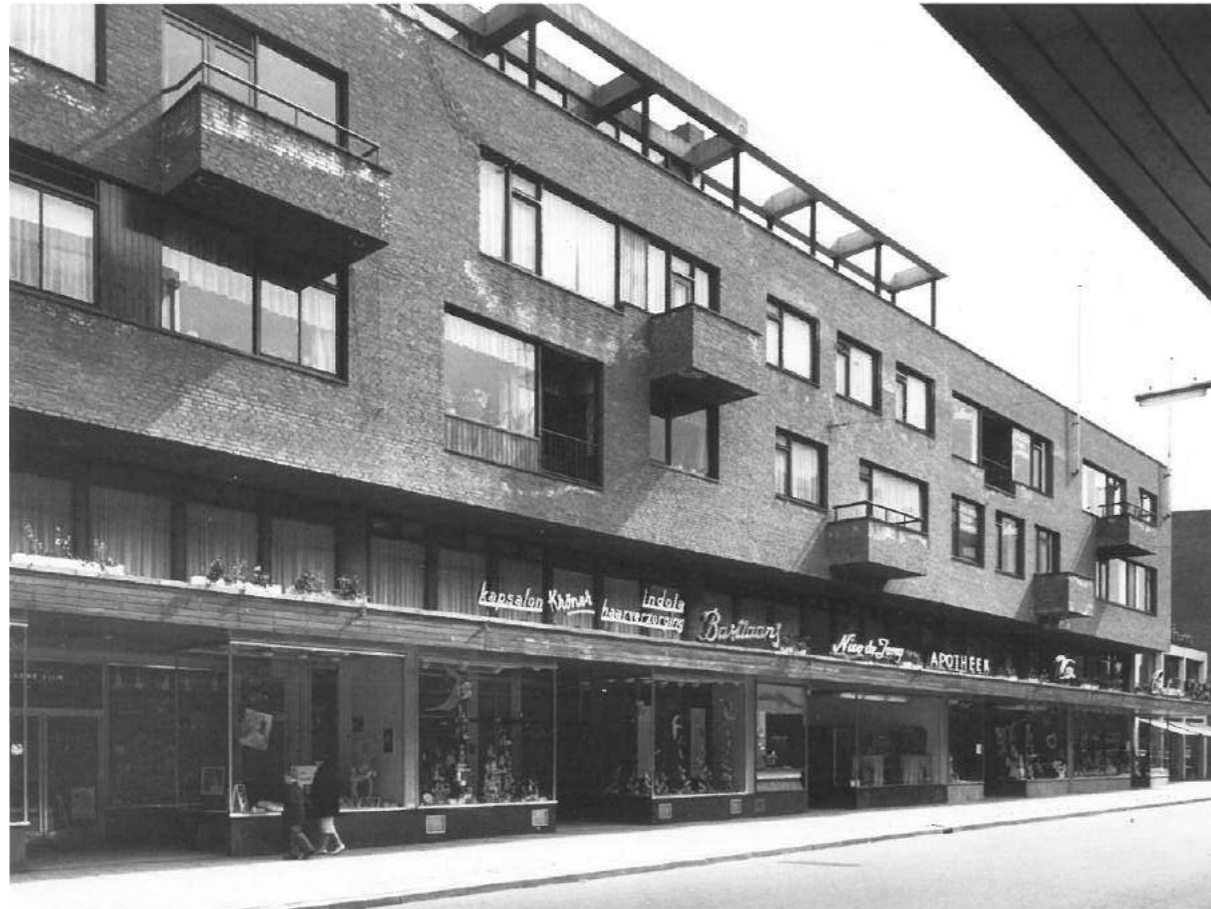
Hermanus Boexstraat als doorlopend volume, met open tussenverdiepingen en reclame op de luifel, 1957
