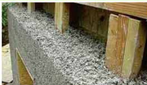
Exemple banché Chaux/Chanvre
