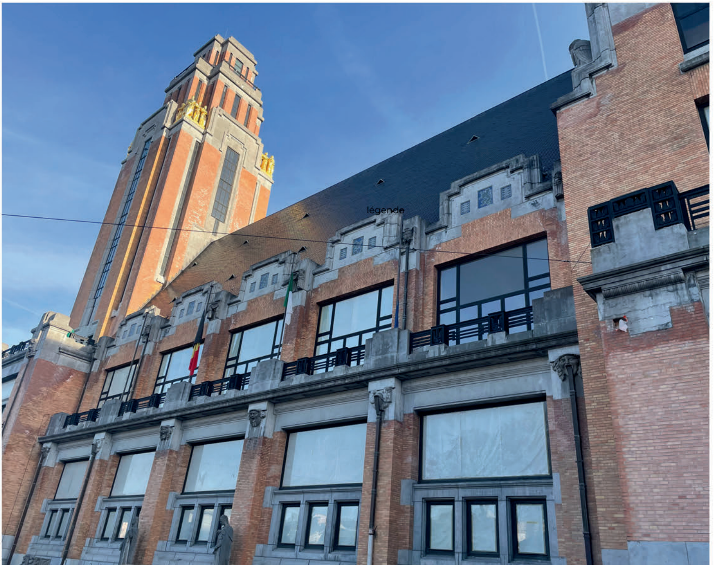
Rénovation de l'hôtel communal
