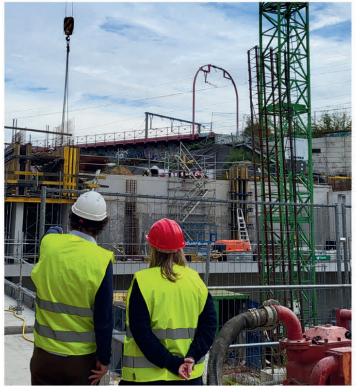
Construction de l'école De Puzzel
