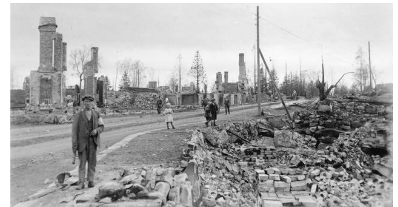
Punaisten polttamia rakennuksia Vammalassa.
