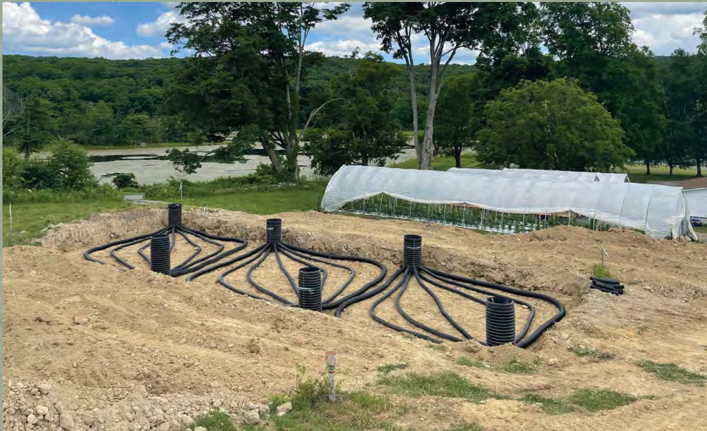
Invernadero con batería climática mientras se construye—la red subterránea de tuberías distribuye el aire caliente captado arriba, Atribución: Glynwood
